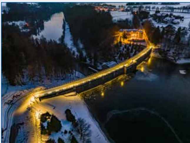
~ VD Pastviny, koruna hráze po rekonstrukci
