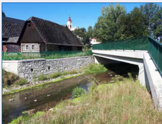
~ Třebovka, protipovodňová úprava v obci Rybník
