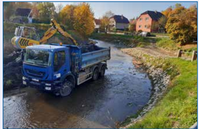
~ Desná, Dolní Újezd, odstraňování nanosů
