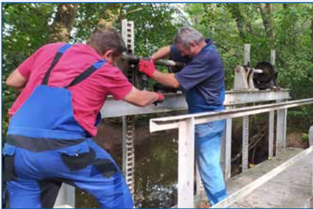
~ Bystřice, Březovice, oprava stavidel
