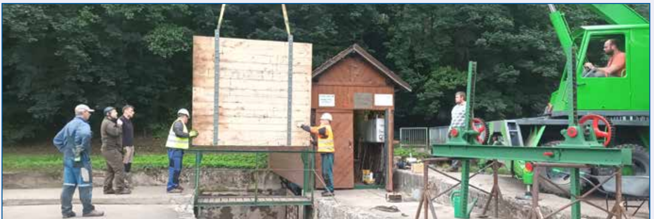
~ Jizera, Dolánky, oprava štěrkové propusti a výdřevy stavidla
