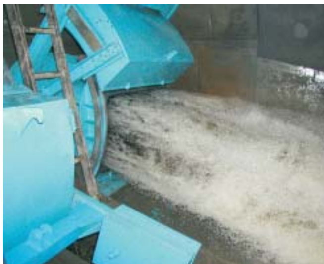
Základová výpust na VD Souš
