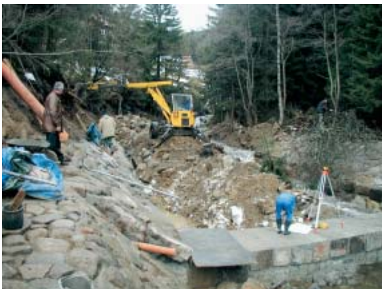
Oprava koryta Úpy v Obřím dole
