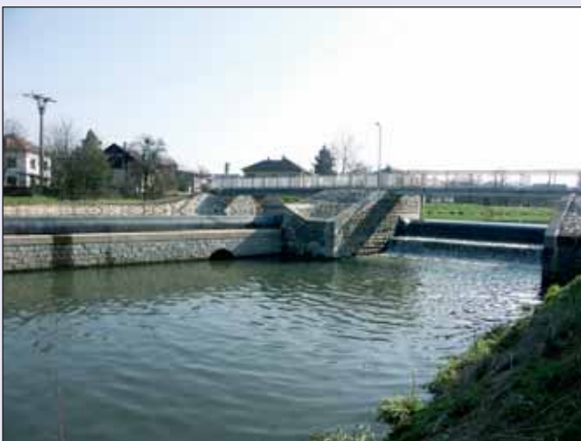
Rekonstruovaný jez na Tiché Orlici v Letohradě
