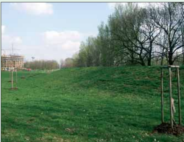
Protipovodňová hráz na pravém břehu Labe v Pardubicích
