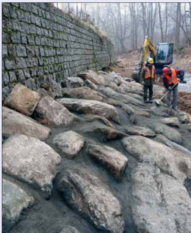
Smědá v Hejnicích, oprava paty pravobřežní zdi
