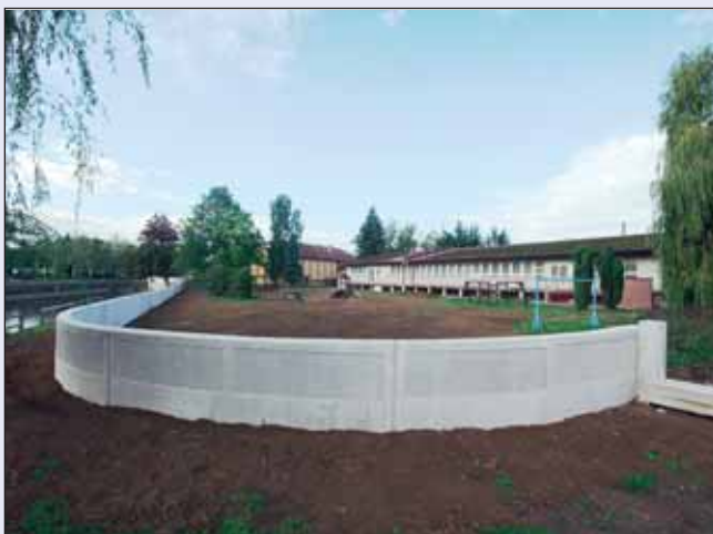
Choceň, protipovodňová ochranná zeď
