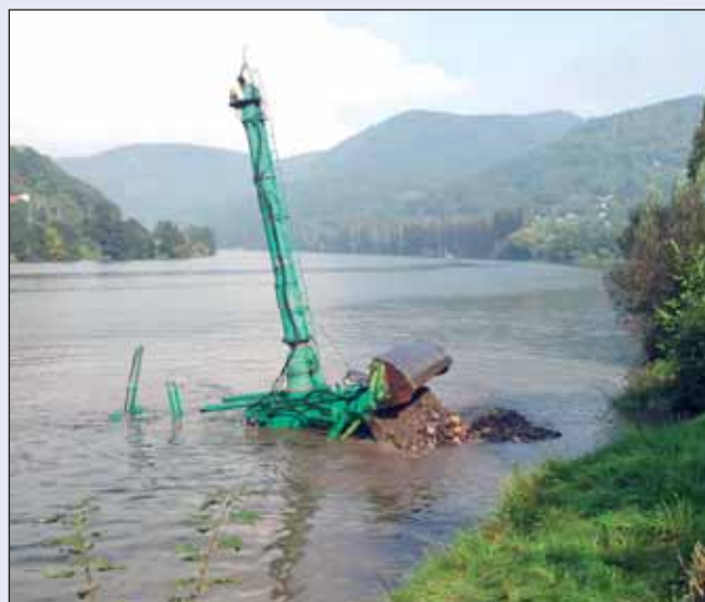
Prohrábka plavební dráhy na dolním Labi
