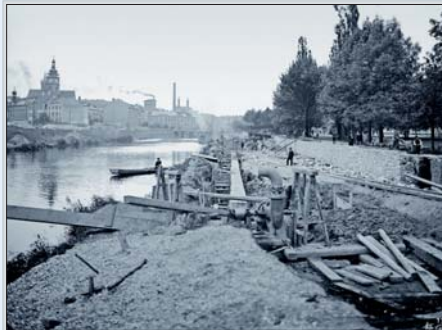
Labe – výstavba nové nábrežní zdi na pravém břehu v prostoru dnešního Tyršova mostu. 1909.
