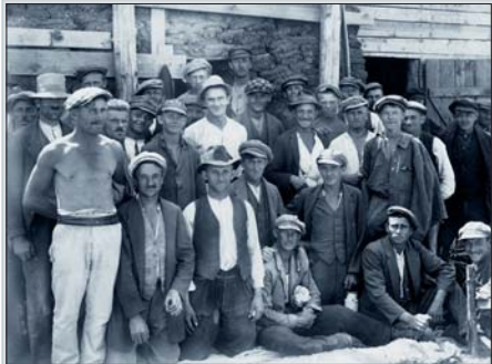
Orlice – dělníci ze stavby Malšovického jezu. 1924.
