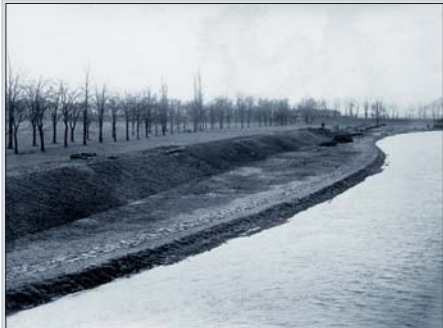
Orlice – upravený levý břeh s ochrannou hrází pod Malšovickým mostem. 1923.
