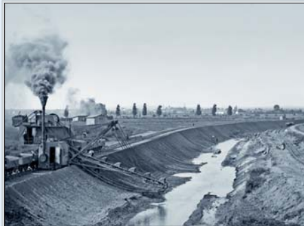
Labe - výstavba nového koryta nad železničním mostem u Věkoš. 1909.
