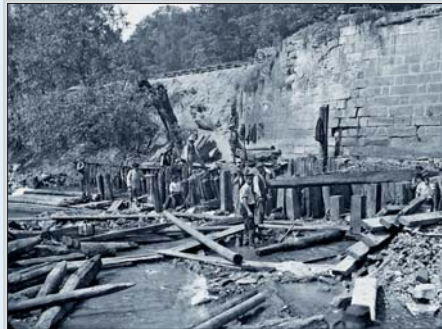
Labe - rozebírání pilotového roštu pod starým jezem Hučák. 1908.
