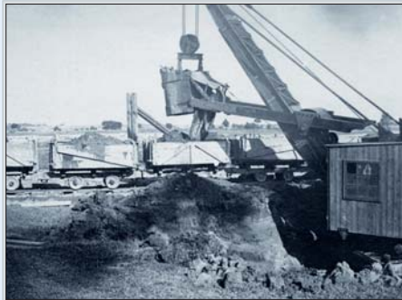
Labe - průkop pod Předměřicemi nad Labem, nakládání vozíků parním bagrem. 1915.
