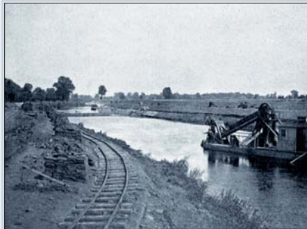
Labe - hloubení koryta nad mostem v Pláckách. 1911.
