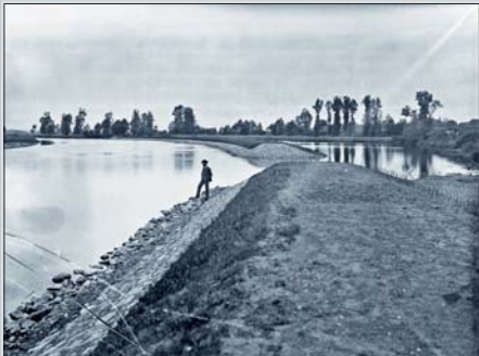
Labe – dokončená úprava pod Hradcem Králové, vpravo rybí útulek. 1908.
