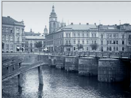
Labe - Pražský pevnostní most s dřevěnými ledolamy. 1908.
