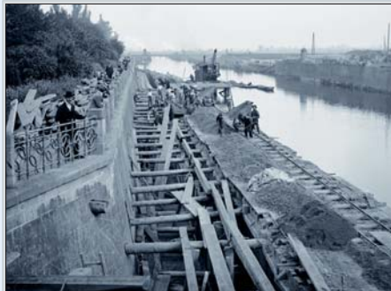
Labe – zajišťování pravobřežní pevnostní zdi nad Pražským mostem. 1909.
