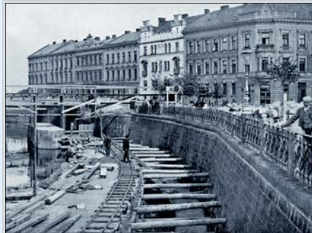
Labe – zajišťování levobřežní pevnostní zdi pod Pražským mostem. 1908.
