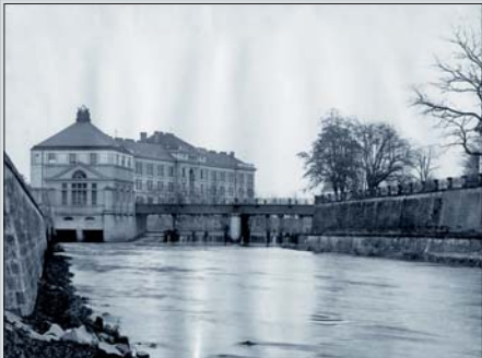
Orlice – dokončený Moravský pohyblivý jez s vodní elektrárnou. 1925.
