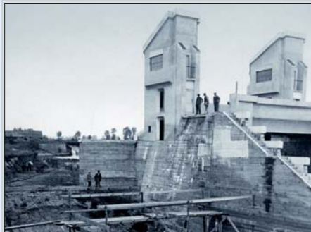
Labe – zakládání vodní elektrárny u prvního pohyblivého jezu v Předměřicích nad Labem. 1917.
