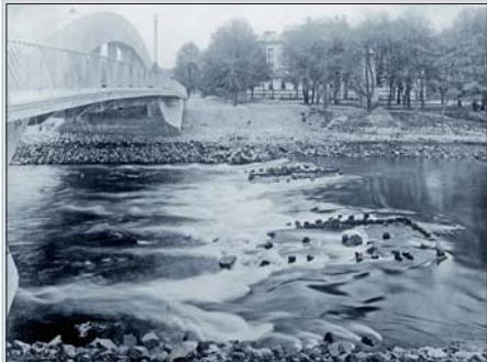
Orlice – zbytky pilířů starého Malšovického mostu. 1925. (Foto: Ateliér Langhans)
