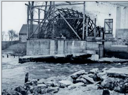
Orlice - zbytky mlýnského kola a protrženého jezu Podhůra ve Svinarech. 1941.
