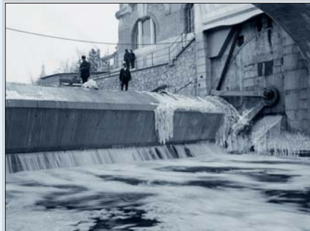
Labe – ruční odřezávání ledu ze segmentového uzávěru nového jezu Hučák. 1912.
