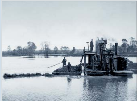
Orlice – bagrování koryta pod Malšovickým jezem. 1926.
