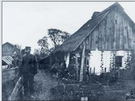
Labe – c. k. dohlížitel pevného jezu v Předměřicích nad Labem u svého domku. 1914.
