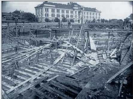
Orlice – bourání pevnostního mostu u Moravské brány (U Fortny). 1910.
