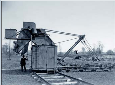
Orlice – mechanizace používaná při svahování koryta řeky. 1925.
