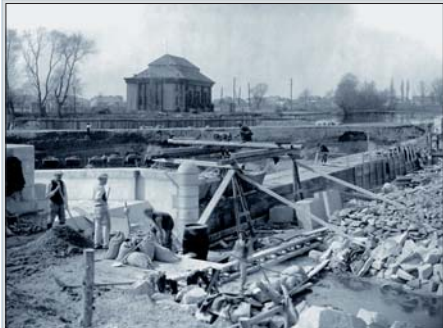
Orlice – staveniště Malšovického jezu. 1925.
