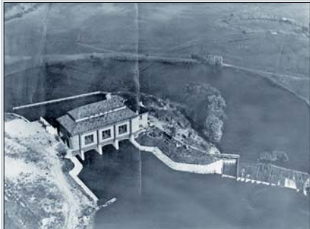
Orlice – dřevěný jez Mlejnek a budova nové vodní elektrárny Malšovice. 1921.
