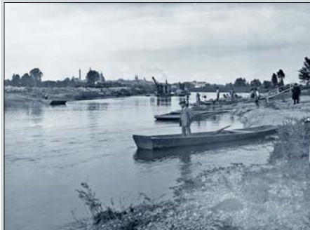
Labe – hloubení koryta a úprava břehů pod Hradcem Králové. 1908.
