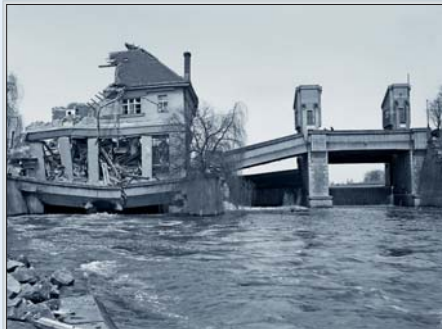
Labe – jez a vodní elektrárna v Přebudicích nad Labem den po havárii vodní elektrárny. 1932
