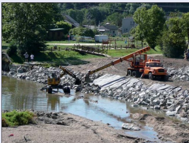
Oprava pravého břehu Jizery, Rožátov
