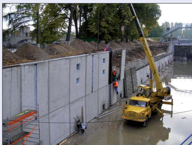
Rekonstrukce zdí plavební komory na Labi, Nymburk
