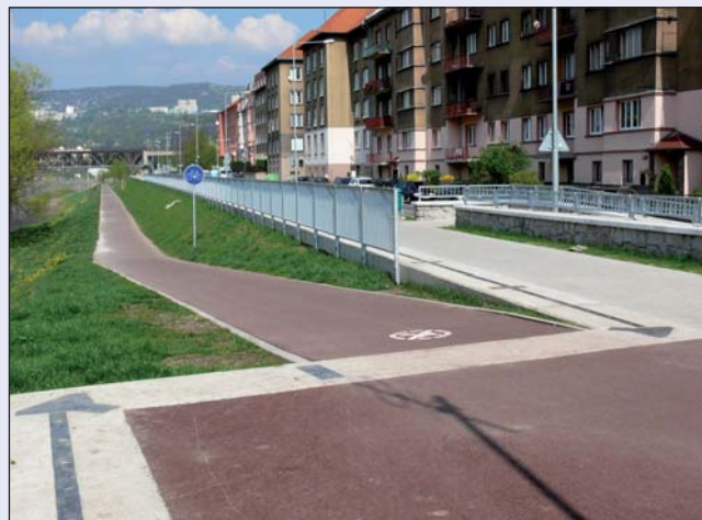
Protipovodňová úprava labského nábřeží, Ústí nad Labem
