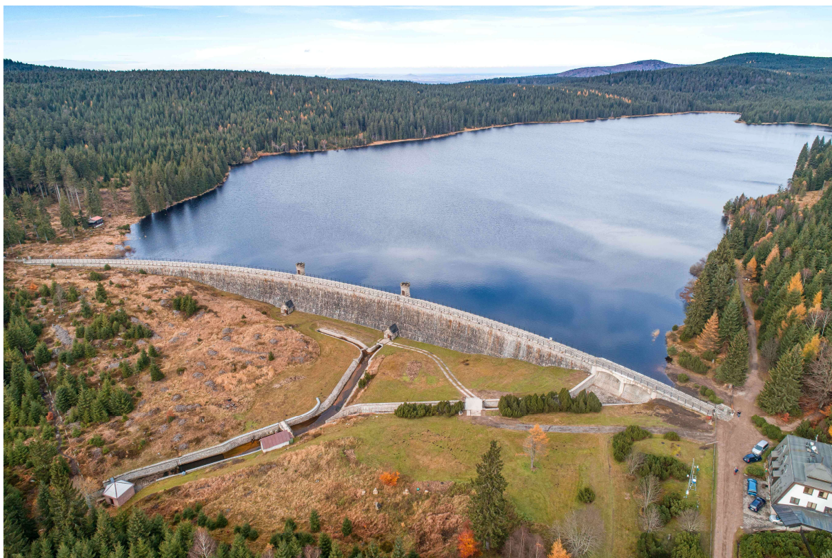
Obrázek 48 - VN Bedřichov po rekonstrukci hráze (rok 2021)
