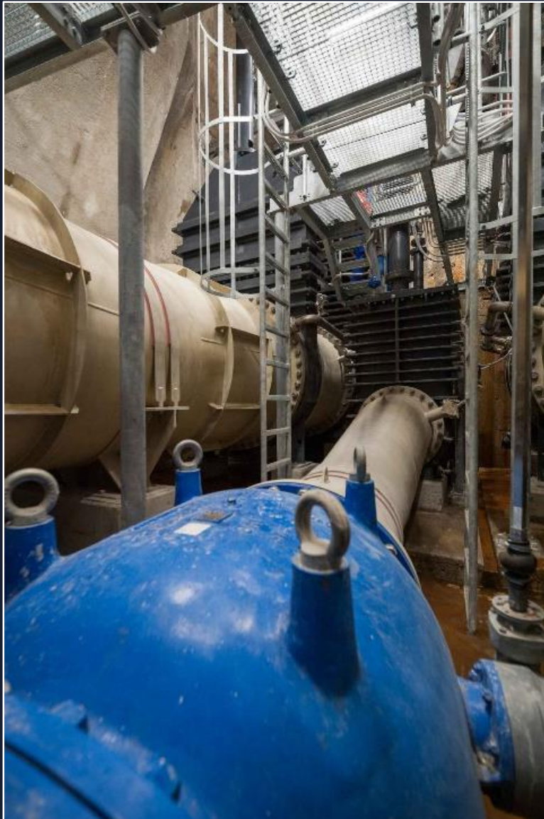
Spodní výpusti byly opatřeny moderními uzávěry a kontrolními prvky.
