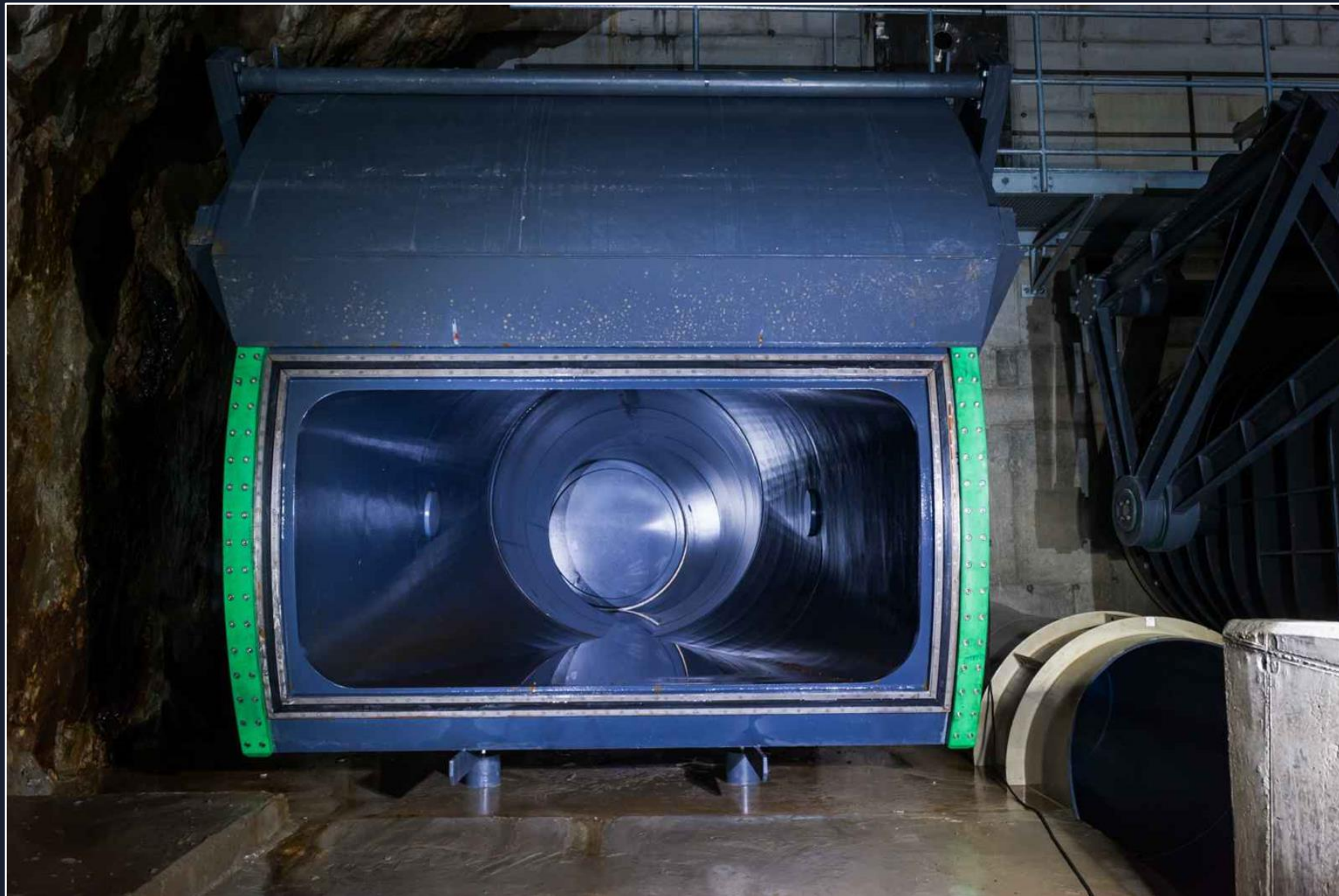
Nový segmentový uzávěr na konci výpusti má rozměry 2,5x1,2 m
