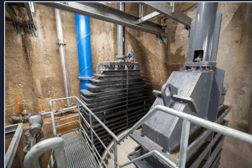
Spodní výpusti byly opatřeny moderními uzávěry a kontrolními prvky.
