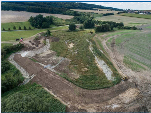
~ Malá vodní nádrž Mlázovice v průběhu rekonstrukce
