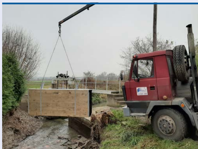
~ Oprava jezu Libaň
