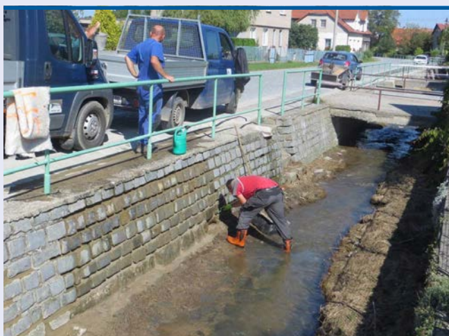
~ Oprava poškozené dlažby u Mrákotínského potoka v Prosetíně
