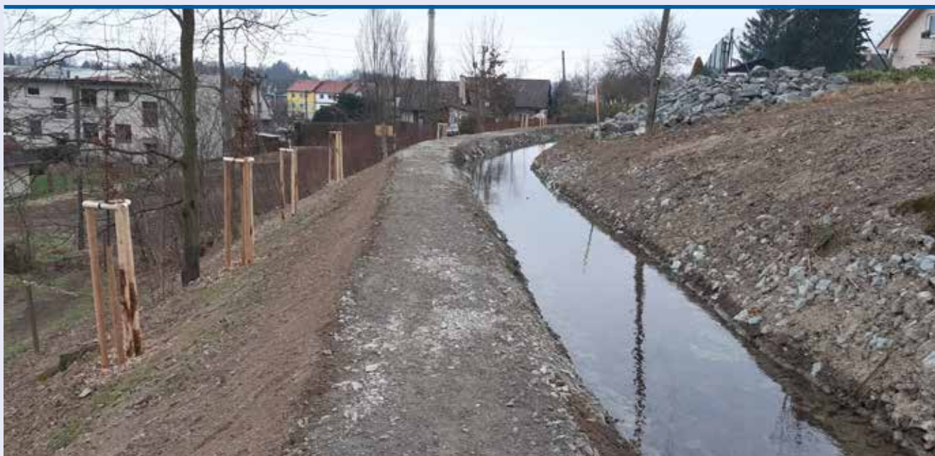
~ Dlouhá strouha v Kvasinách po rekonstrukci
