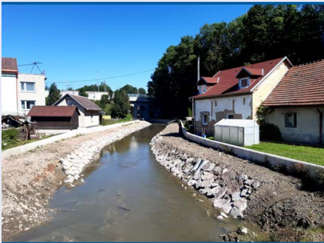
~ Výstavba protipovodňových opatření na Třebovce
