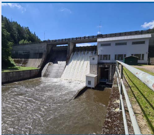
~ Zkouška klapkových uzávěrů na VD Křižanovice
