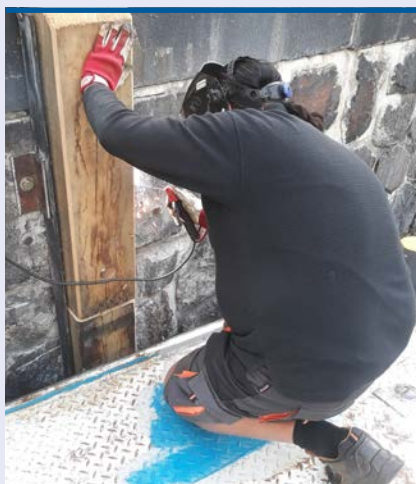
~ Výměna dubového těsnění na plavební komoře Střekov
