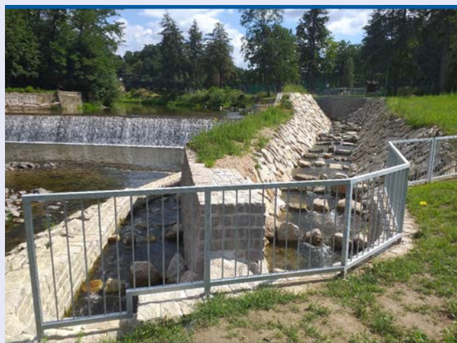
~ Rybí přechod Frýdlant
