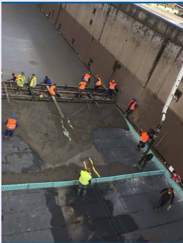
~ Betonáž dna plavební komory Kostomlátky
