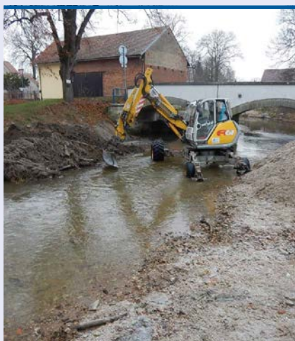
~ Obnova průtočného profilu na Novohradce v Lozicích
