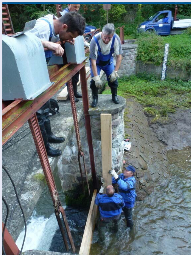
~ Oprava stavidla jezu v Dolním Újezdu
