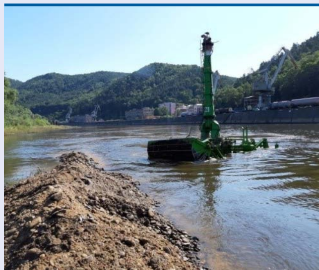
~ Prohrábka plavební dráhy na LVC
