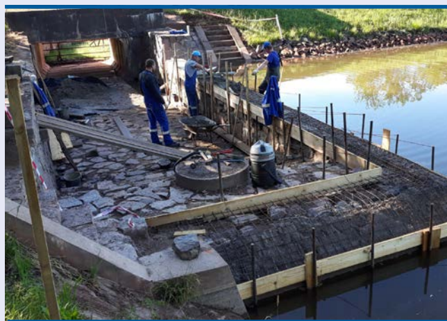
~ Oprava bezpečnostního přelivu malé vodní nádrže Štěpanice
