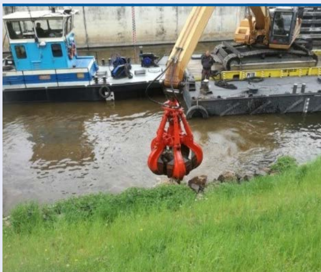
~ Oprava kamenného záhozu v n VD České Kopisty
