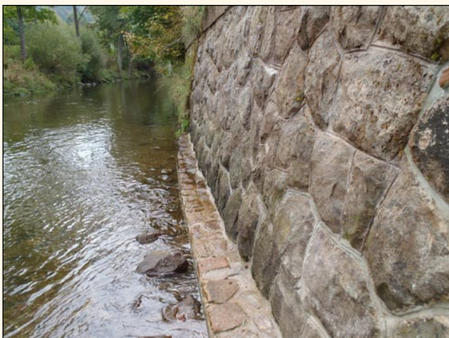
Úpa, Bohuslavice, oprava zdi
