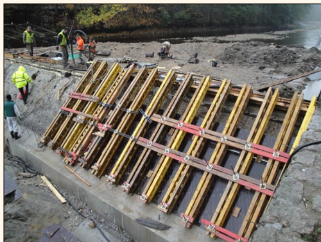
Jizera, Horní Sytová, oprava jezu
