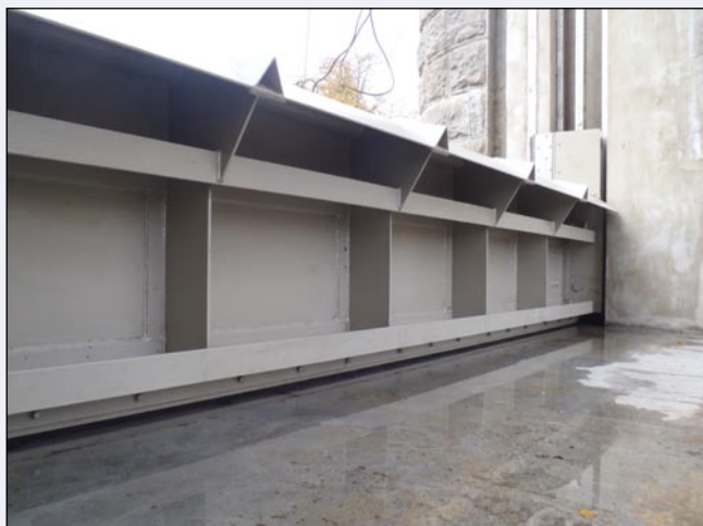
Orlice, Albrechtice nad Orlicí, rekonstruovaný uzávěr vorové propusti
