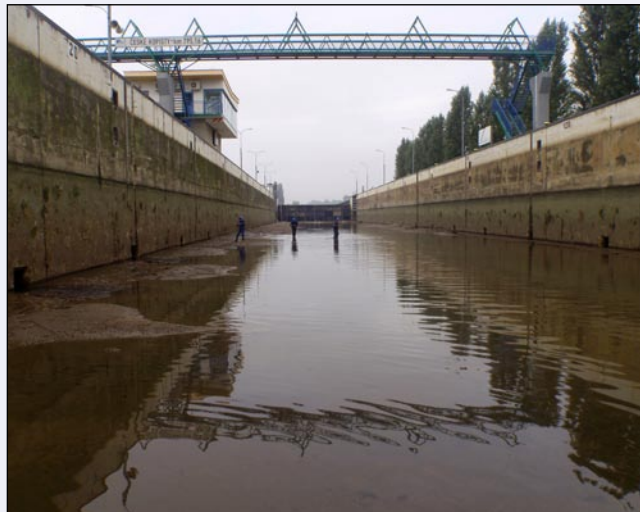
Labe, České Kopisty, vyčerpaná velká plavební komora
