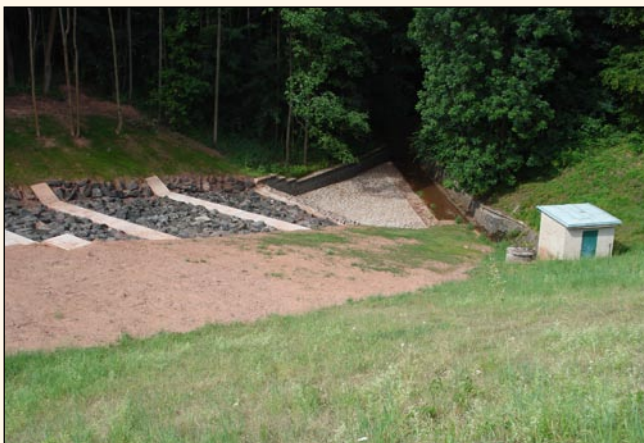
Prosečský potok, VD Jahodnice, oprava bezpečnostního přelivu
