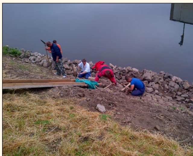
Labe, České Kopisty, oprava opevnění
