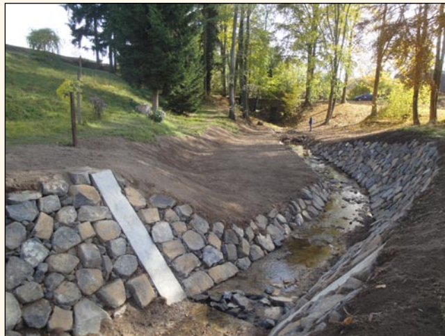
Brusnický potok, Dolní Brusnice, obnova koryta
