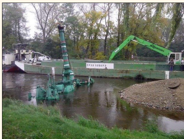
Labe, Dolní Berkovice, obnova průtočného profilu
