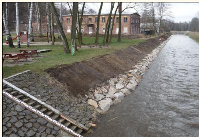
Lužická Nisa, Hrádek nad Nisou, oprava opevnění koryta
