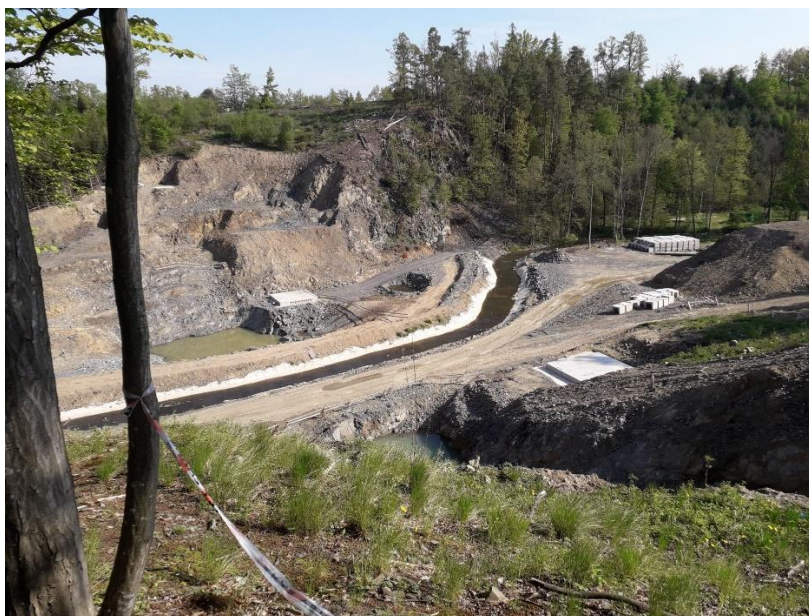
Staveniště v květnu 2022
