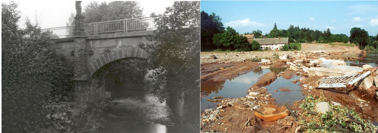
Původní most v Cháborech a destrukce mostu i celého území po povodni
