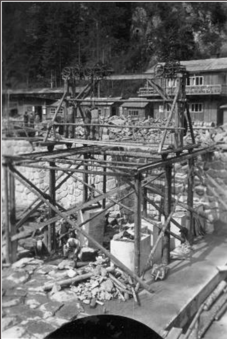
Fotografie z různého období stavby zachytily stroje a pracovní pomůcky používané na stavbě přehrady (na snímcích portálový řetězový ruční jeřáb a injektážní souprava pro pumpování betonu do přípojovacích a těsnících vrtů).
