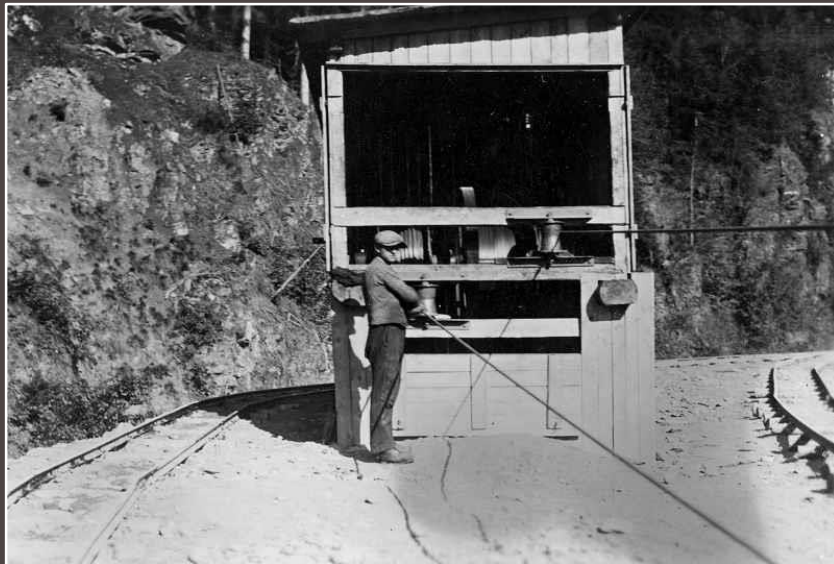
Fotografie z různého období stavby zachytily stroje a pracovní pomůcky používané na stavbě přehrady (na snímku vlevo dole lanový výtah pro vozíky s materiálem).
