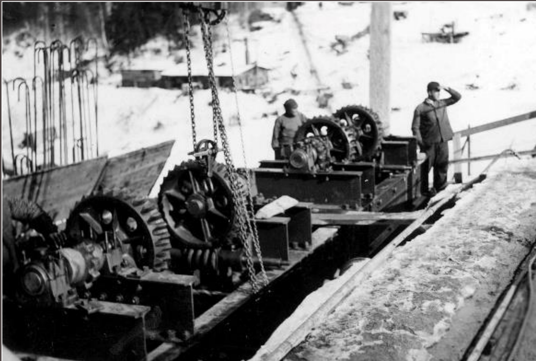
Zařízení strojovny bylo osazeno v roce 1938 a slouží dodnes.
