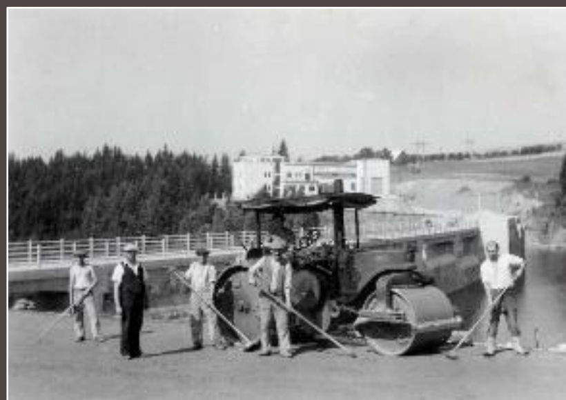
Dokončovací práce na koruně hráze
