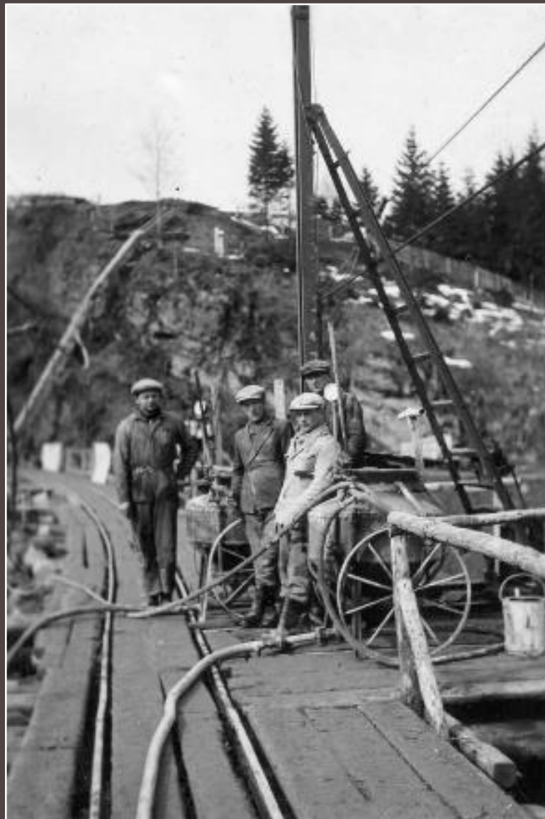
Fotografie z různého období stavby zachytily stroje a pracovní pomůcky používané na stavbě přehrady (na snímcích portálový řetězový ruční jeřáb a injektážní souprava pro pumpování betonu do přípojovacích a těsnících vrtů).
