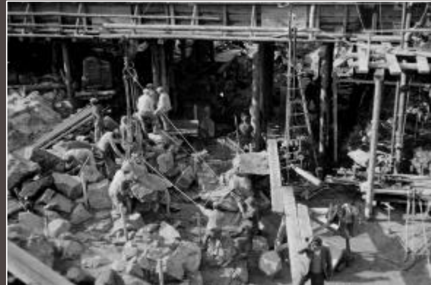
Fotografie z různého období stavby zachytily stroje a pracovní pomůcky používané na stavbě přehrady (na snímku vlevo dole lanový výtah pro vozíky s materiálem).
