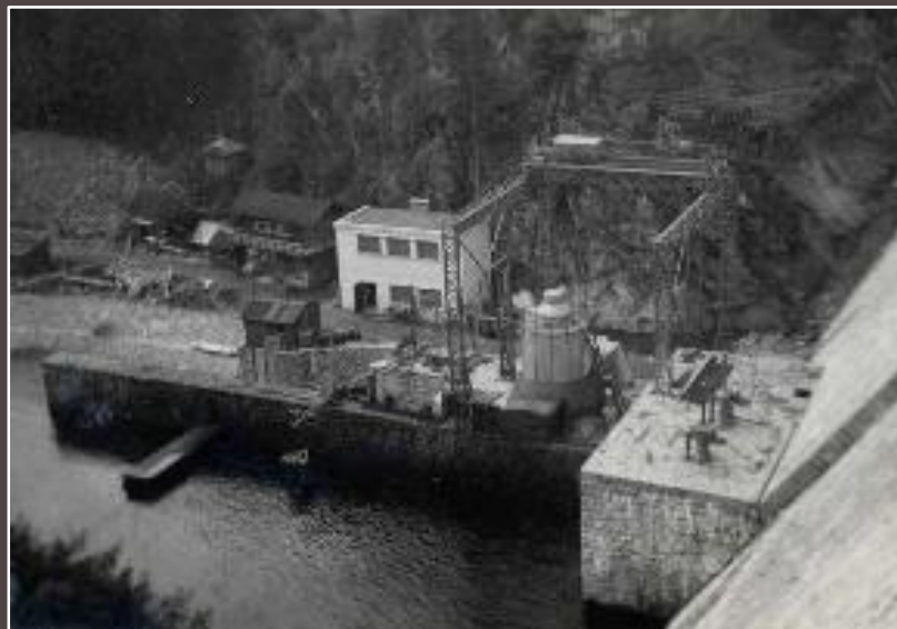
Montáž technologie vodní elektrárny a pokládka kabelů v těsné blízkosti hráze v roce 1938
