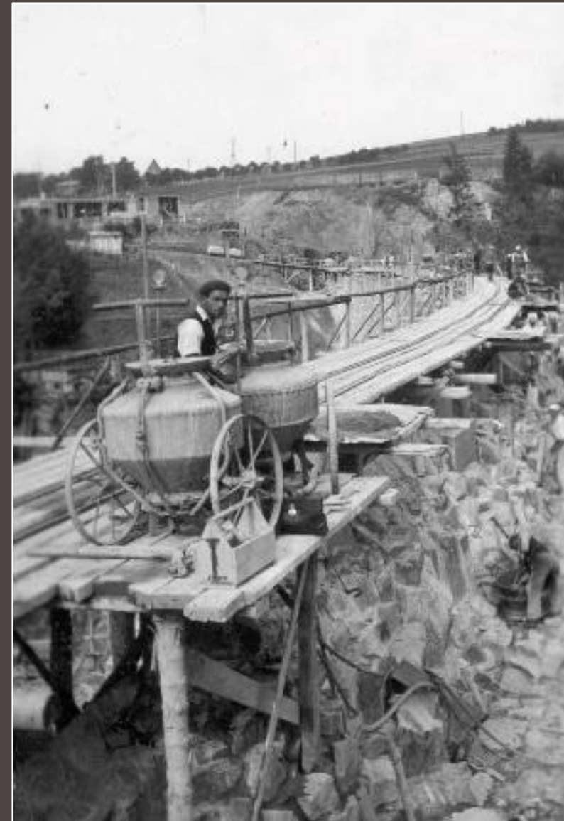
Fotografie z různého období stavby zachytily stroje a pracovní pomůcky používané na stavbě přehrady (na snímcích portálový řetězový ruční jeřáb a injektážní souprava pro pumpování betonu do přípojovacích a těsnících vrtů).
