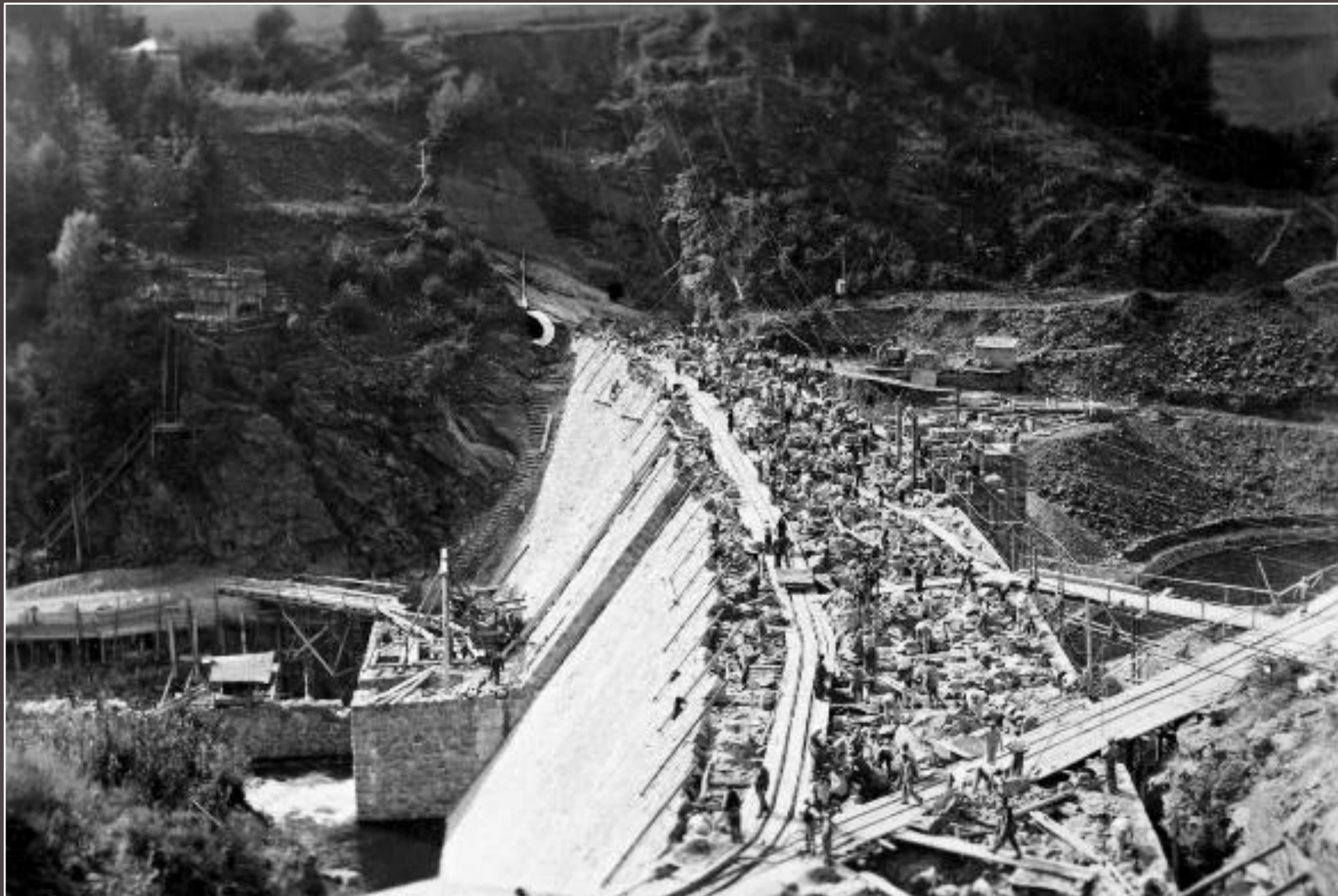
Pohled na rostoucí hráz v roce 1936
