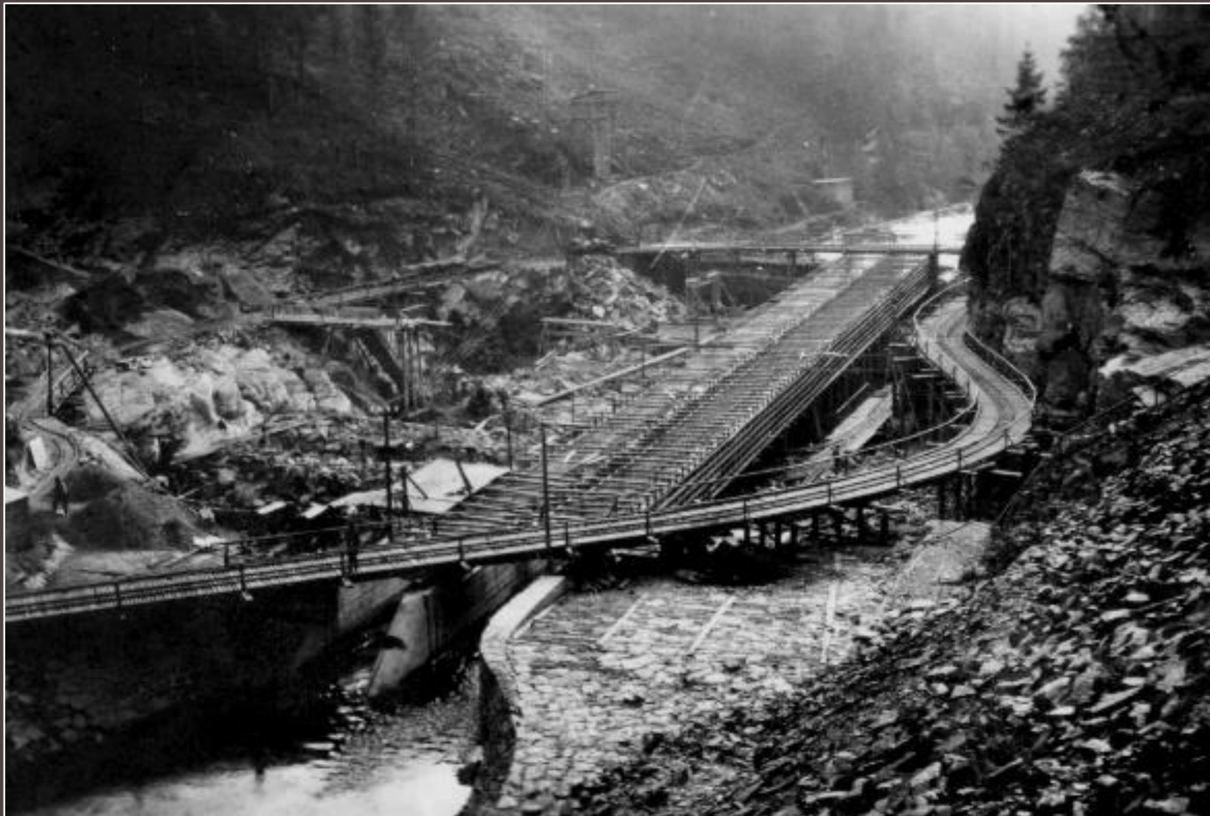
Pohled na staveniště v roce 1934
