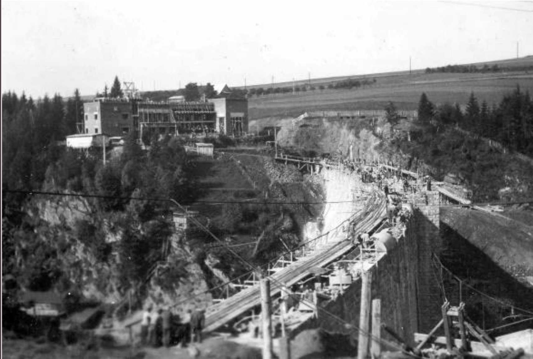
V popředí probíhá zdění přelivné hrany korunového přelivu, na protějším břehu roste správní budova vodní elektrárny.
