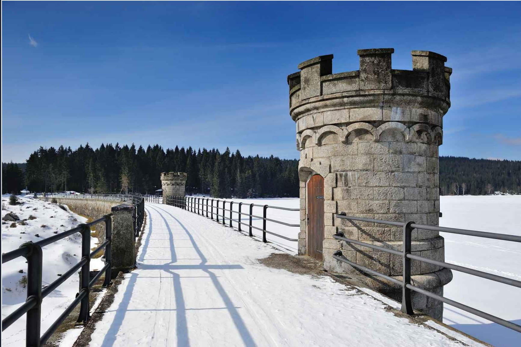
Délka hráze v koruně je 340 m, výška hráze nad terénem 15 m, výška hráze nad základovou spárou 23 m.
