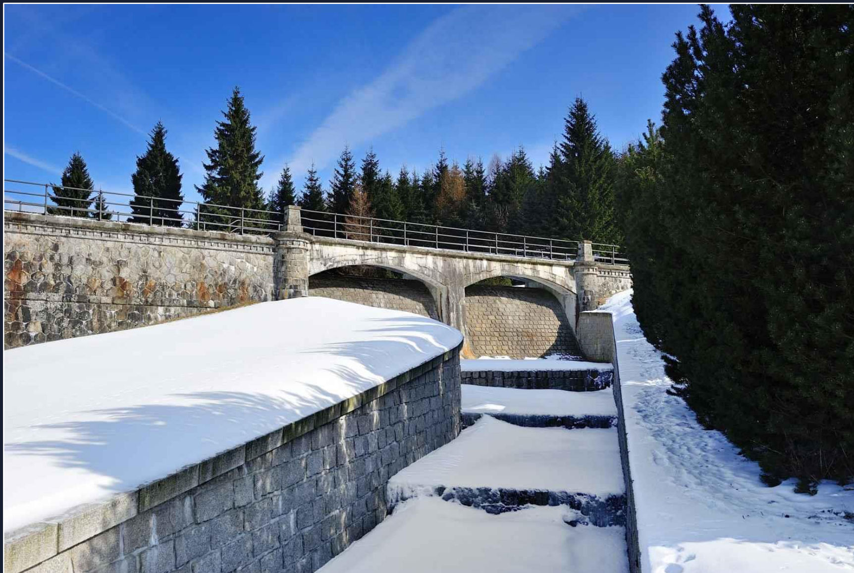
Při levém zavázání hráze je nehrazený bezpečnostní přeliv o dvou polích, na který navazuje kaskádový odpad od přelivu.
