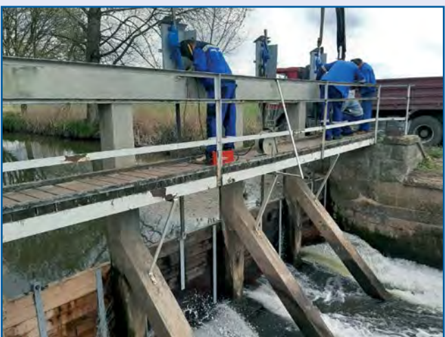
~ Oprava stavidel a mechanismů na jezu ve Vlhošti
