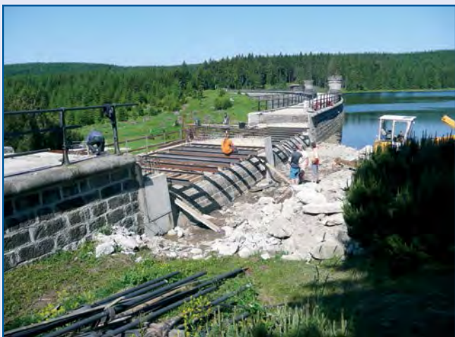
~ Rekonstrukce koruny hráze VD Bedřichov
