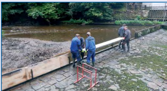
~ Oprava karetek na jezu v Liticích nad Orlicí
