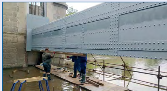
~ Výměna těsnění na Moravském jezu v Hradci Králové
