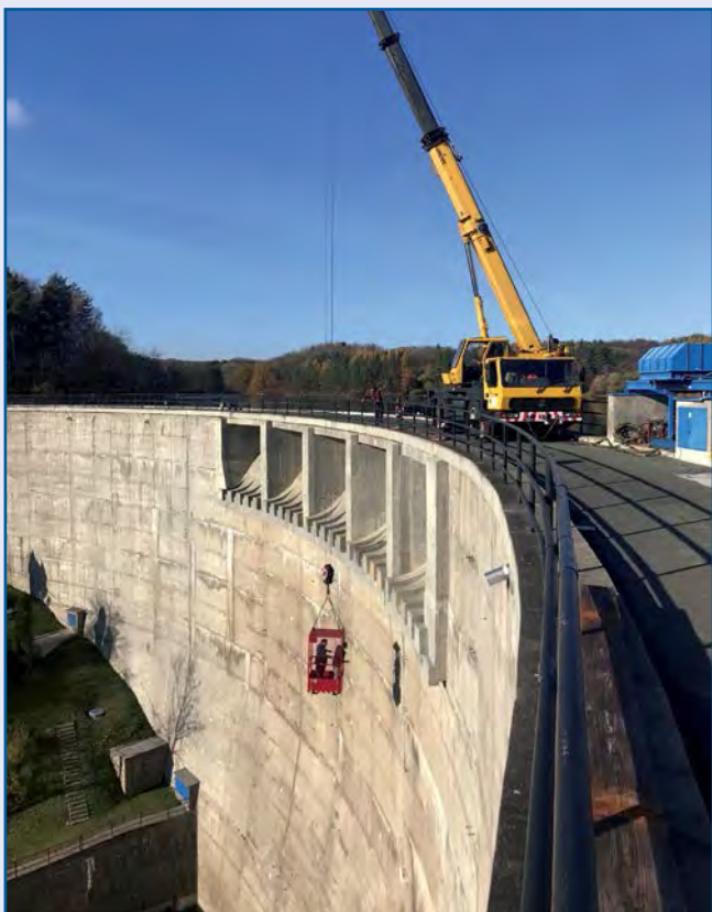
~ Oprava vzdušného líce hráze VD Vrchlice
