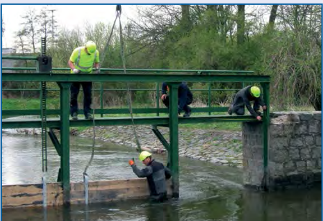
~ Výměna stavidel jezového uzávěru na Vlkavě
