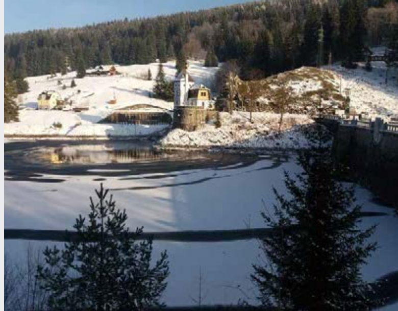
▲ Vodní dílo Labská, původní domek hrázného nad šachtou uzávěrů
