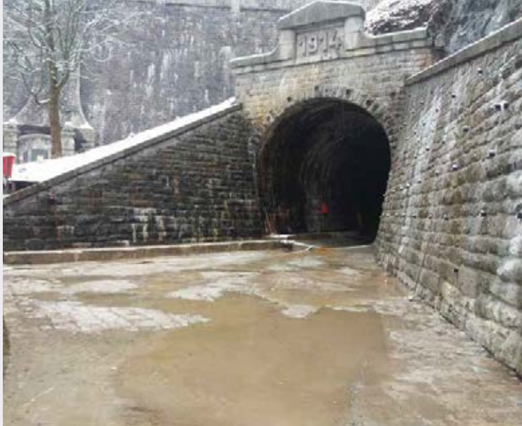
▲ SO 08 Rekonstrukce levobřežní zdi na výtoku, výtokový portál tunelu s emblémem letopočtu 1914 značícím období výstavby přehrad
