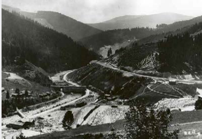
▲ Přehradní profil s přehrázkou u budoucího vtoku do odtokového tunelu (1911)
