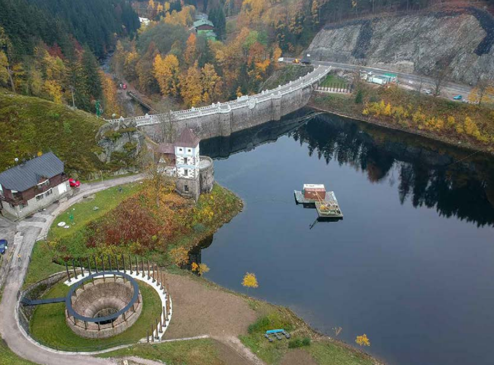
▲ Vodní dílo Labská, pohled z návodní strany
