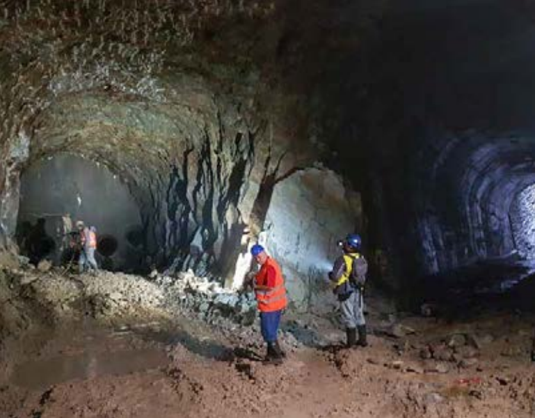
▲ Rozplet v odtokové komoře – původní stav
