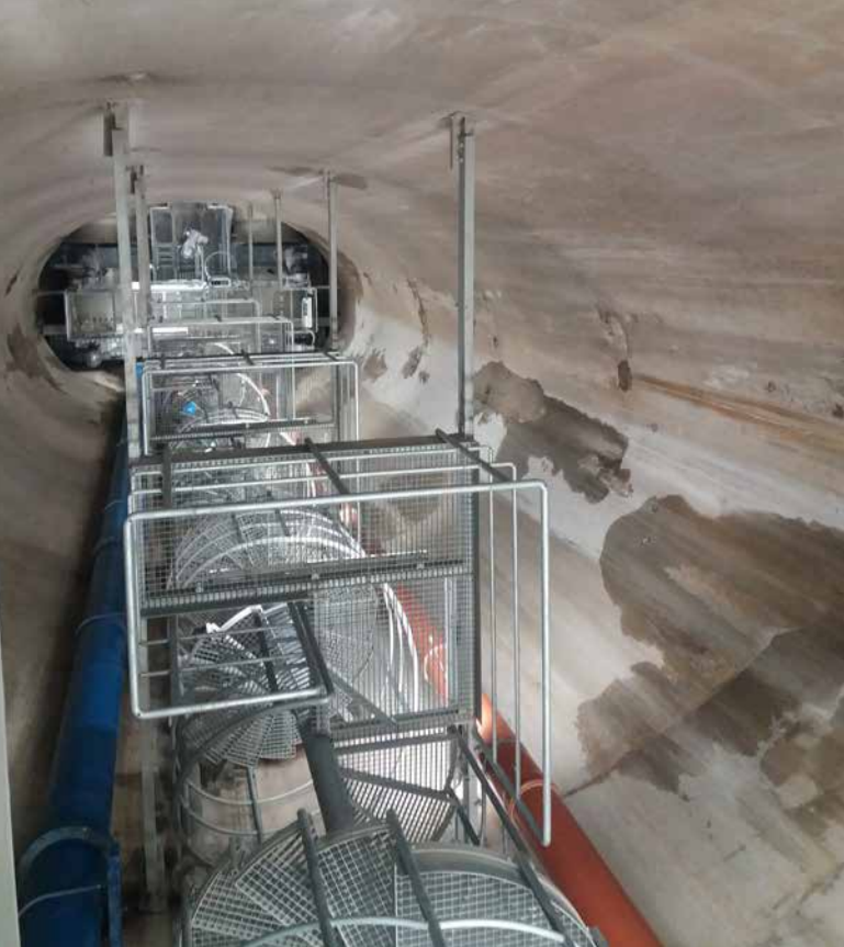
▲ SO 05 Vystrojení přístupové šachty
