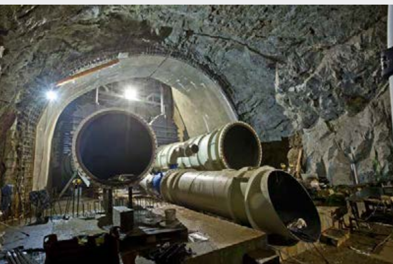
▲ SO 01 Strojovna uzávěrů ve výstavbě
