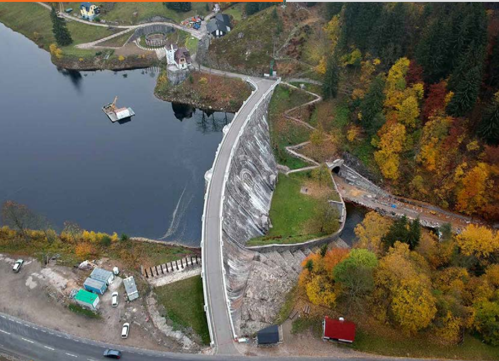
▲ Vodní dílo Labská, celkový pohled
