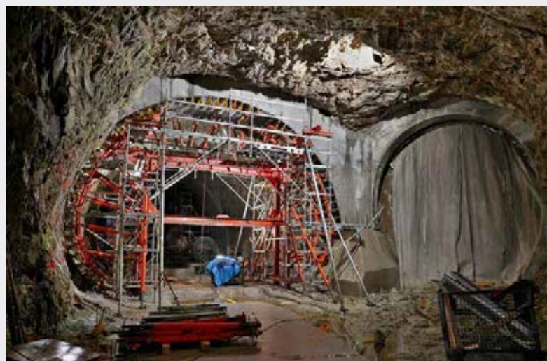
▲ SO 03 Realizace velkého podpěrného rámu na rozpletu
