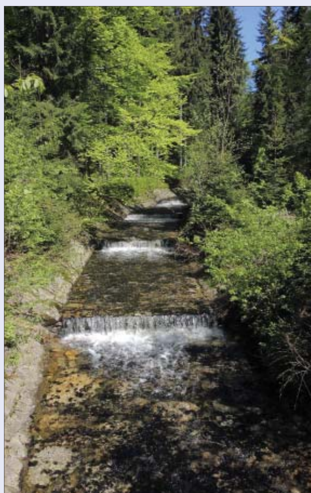
Obr. 67 Dlážděné žlaby mezi jednotlivými stupni na Medvědí potoce
