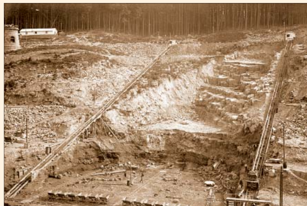
Obr. 55 Levobřežní zářez pro zavázání přehradní hráze, 1912
