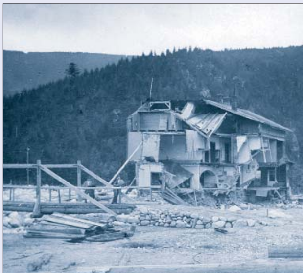
Obr. 35 Provizorní lávka u zříceného hotelu U německého císaře ve Špindlerově Mlýně, 1897
