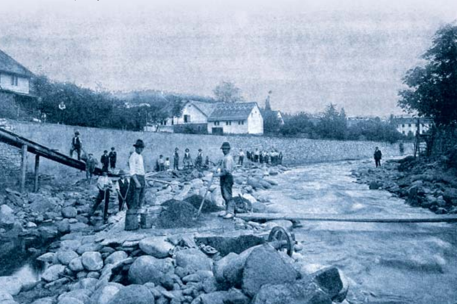
Obr. 33 Úprava koryta Labe ve Vrchlabí, 1908
