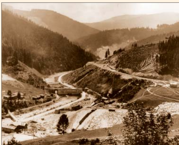
Obr. 44 Stav prací v roce 1911
