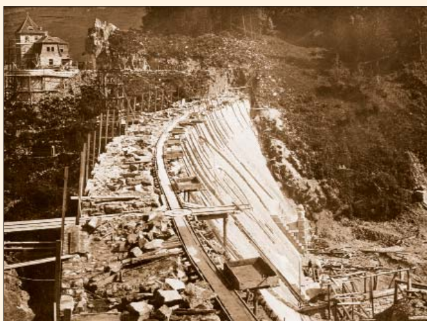
Obr. 48 Stav prací v roce 1914
