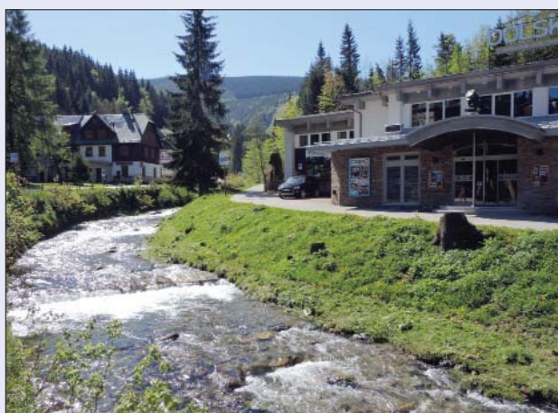
Obr. 72 Současný stav úpravy Dolského potoka
