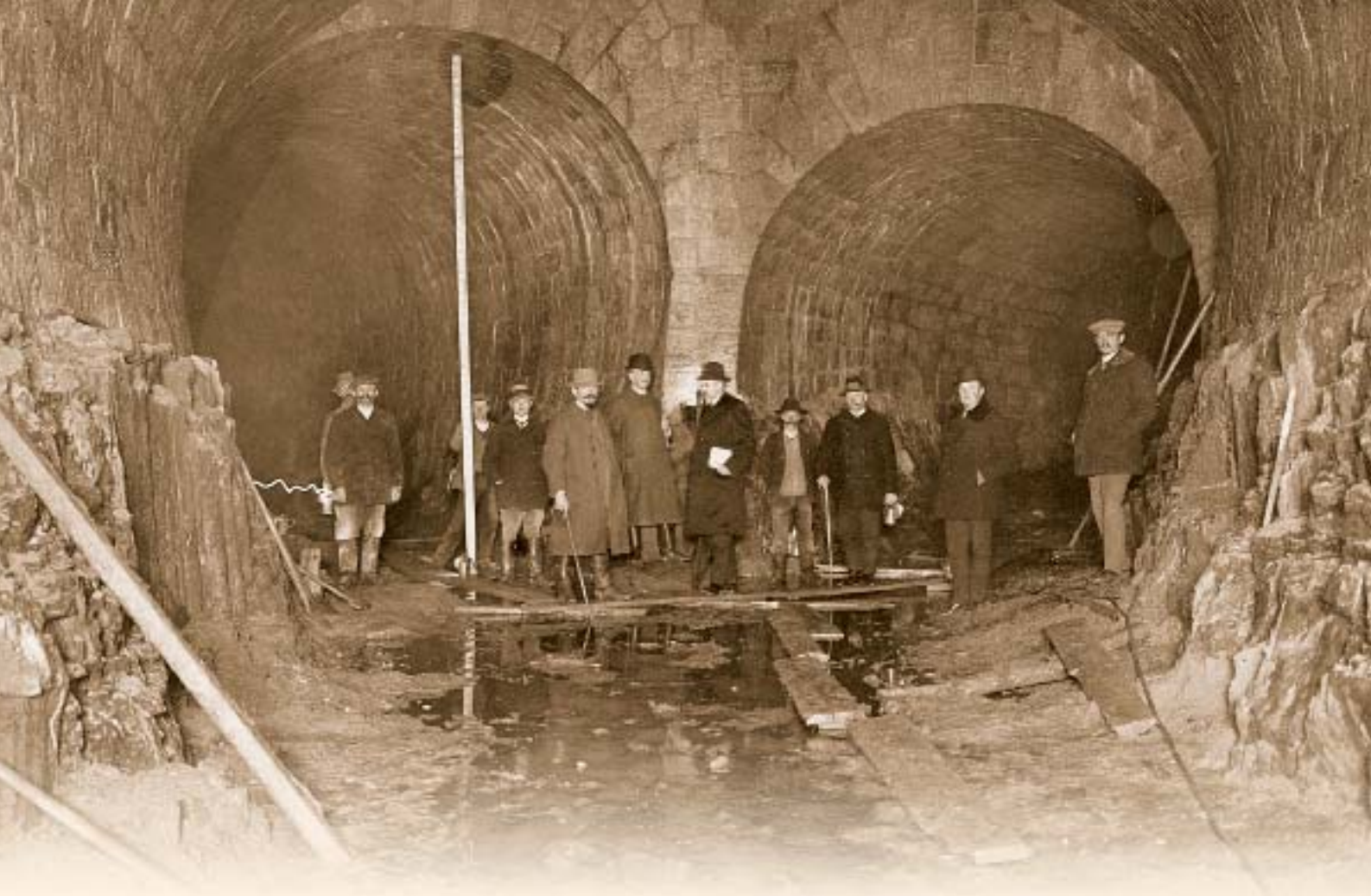
Obr. 42 Kontrolní den ve stykové komoře obtokové a přepadové šachty na přehradě Les Království, 1911
