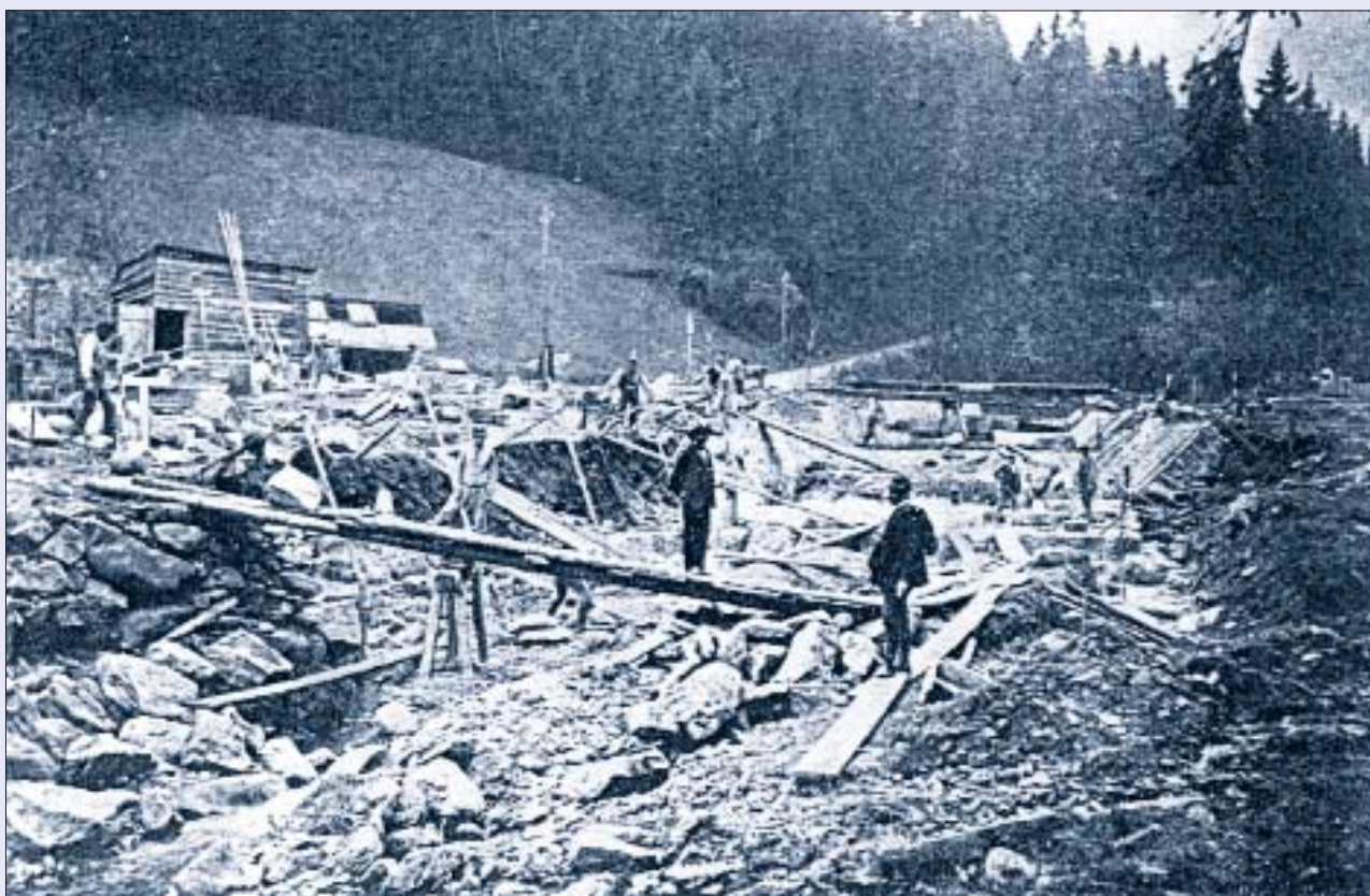
Obr. 71 Úprava výustní části Dolského potoka, 1907
