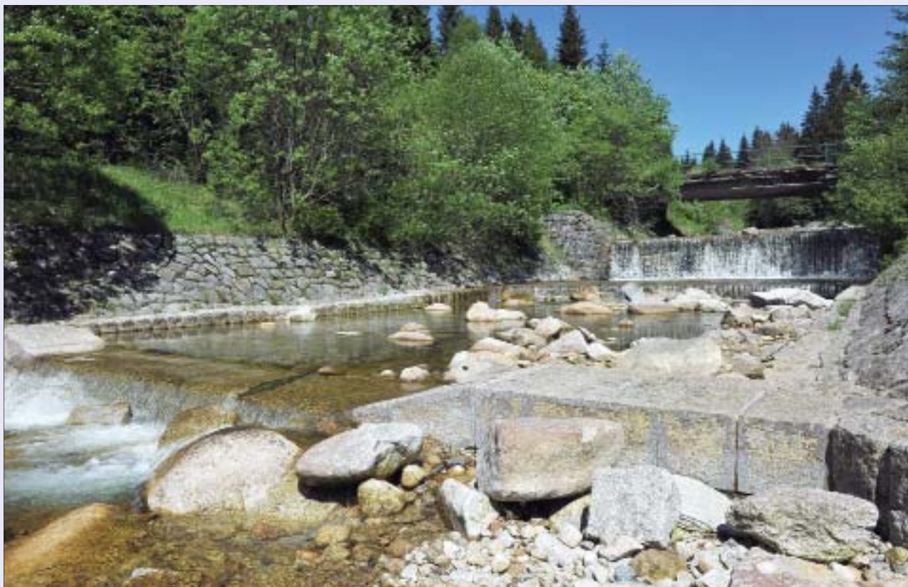
Obr. 61 Hrazenářské práce na Labi před soutokem s Bílým Labem
