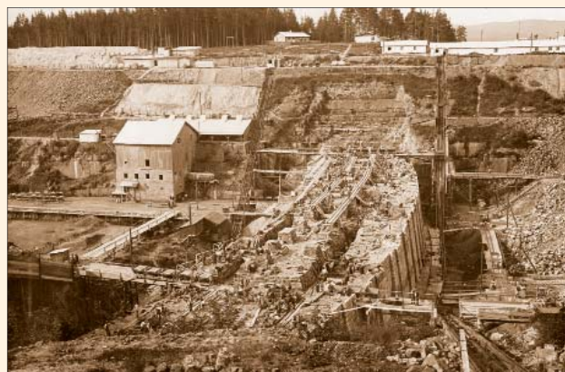
Obr. 57 Stav prací v roce 1913
