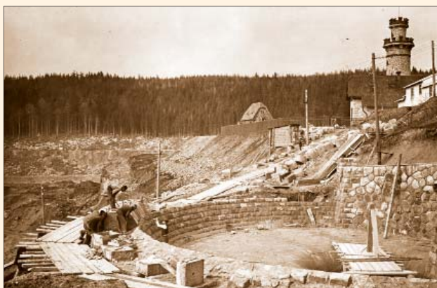
Obr. 56 Dokončovací práce na pravobřežním šachtovém přelivu, 1912
