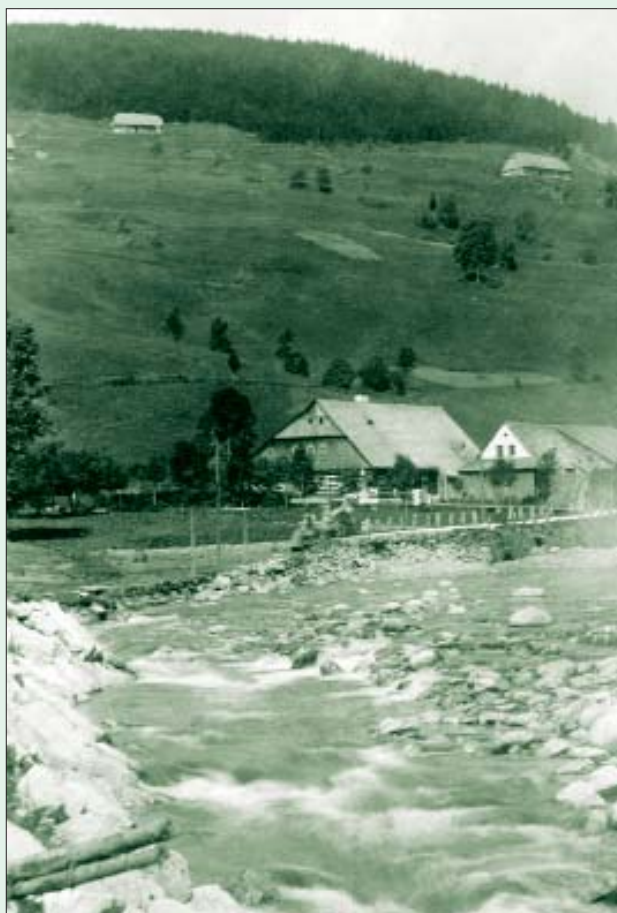
Obr. 23 Zřícená silnice u Krausova mlýna po povodni v roce 1882
