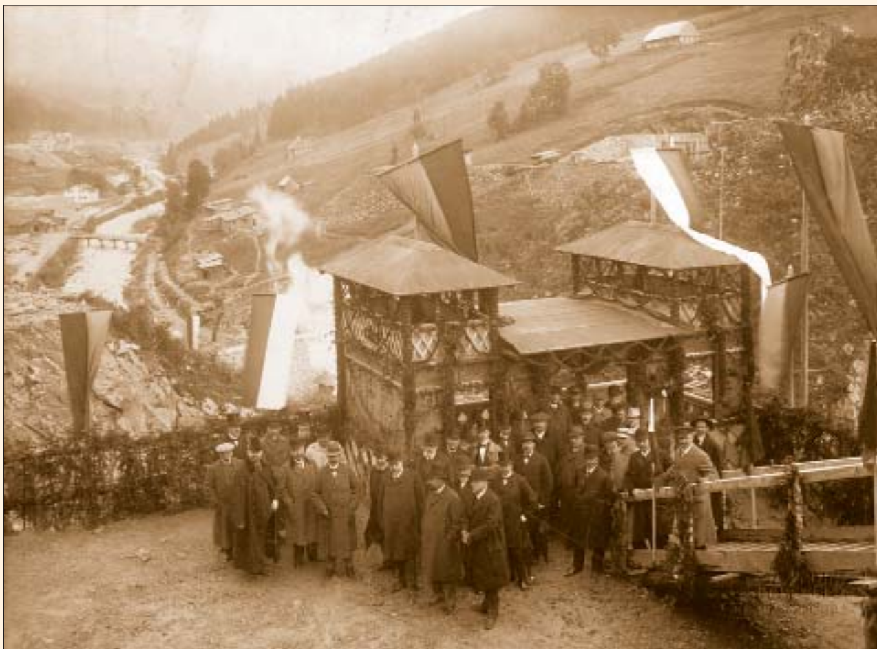
Obr. 43 Kontrolní den na přehradě Labská, 1912
