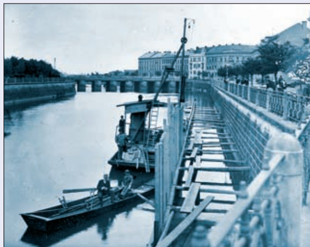
Obr. 49 Zajišťovací práce levé nábrežní zdi pod Pražským pevnostním mostem (1908)
