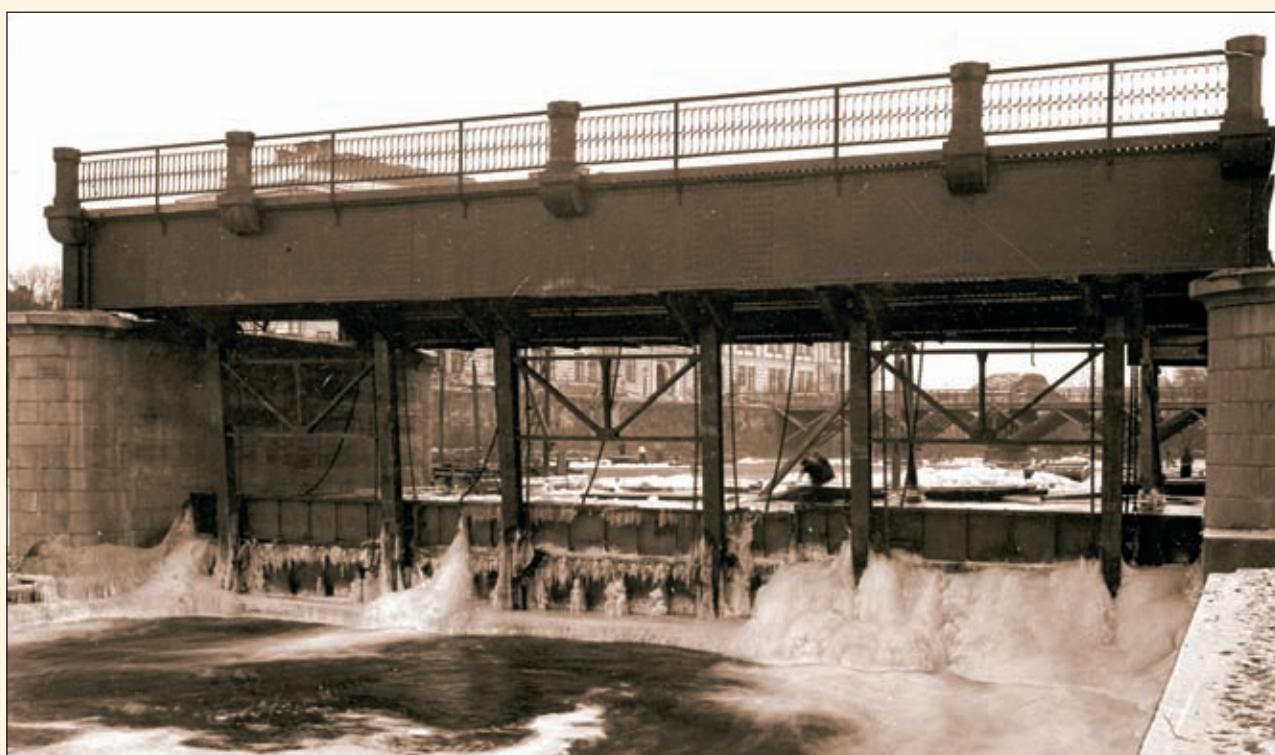
Obr. 74 Konstrukce levého pole Moravského jezu I. (1913)
