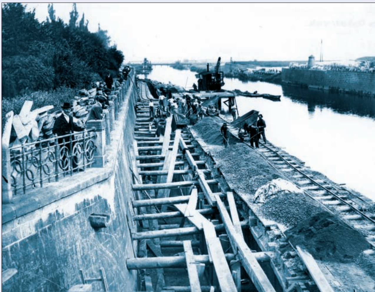
Obr. 48 Zajišťovací práce levé nábrežní zdi nad Pražským pevnostním mostem (1908)
