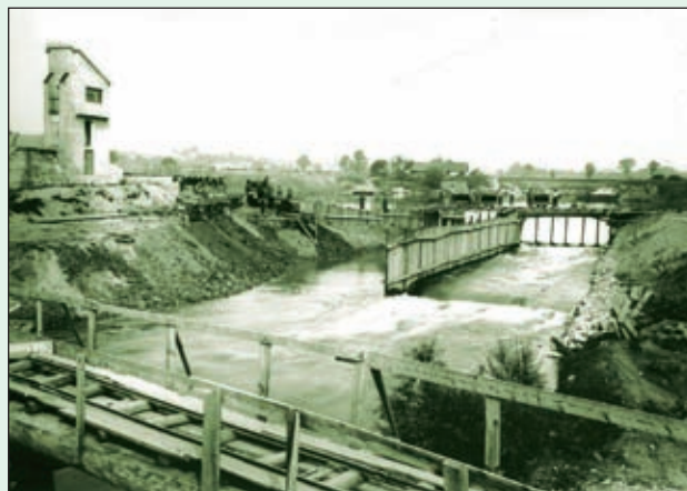
Obr. 59 Obtokové koryto při výstavbě jezu I (1915)
