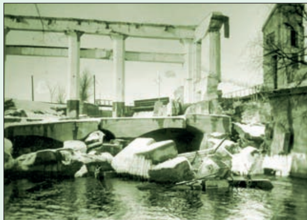
Obr. 62 Zbytky zřícené vodní elektrárny (1932)
