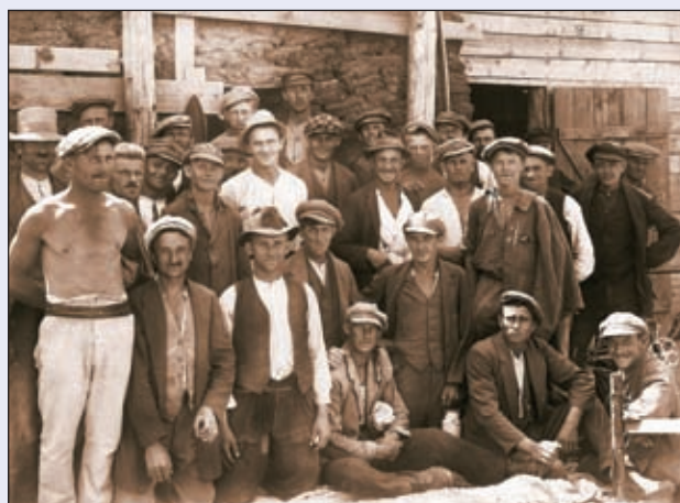
Obr. 69 Dělníci zaměstnaní na stavbě Malšovického jezu (1926)
