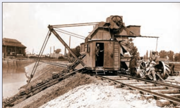
Obr. 68 Mechanizace používaná při svahování (1923)
