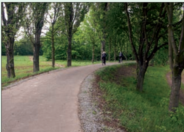
Obr. 94 Rekonstruované ochranná hráz na levém břehu Labe ve Třebši
