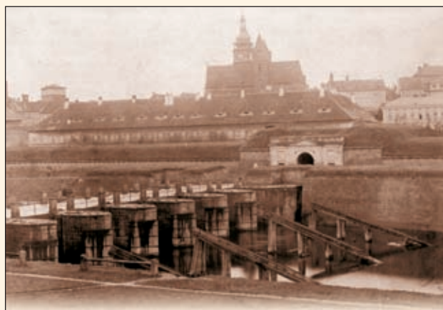
Obr. 31 Moravský pevnostní most s ledolamy (kobyly) (konec 19. stol.)
