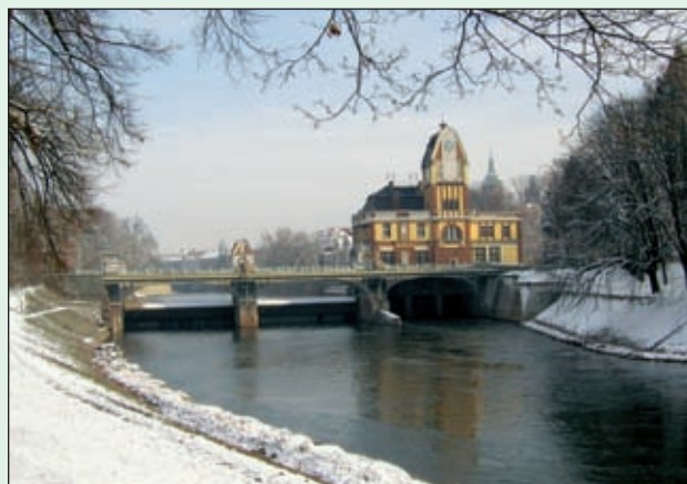
Obr. 37 Jez Hučák na Labi s budovou vodní elektrárny a mostem – architekt Fr. Sander
