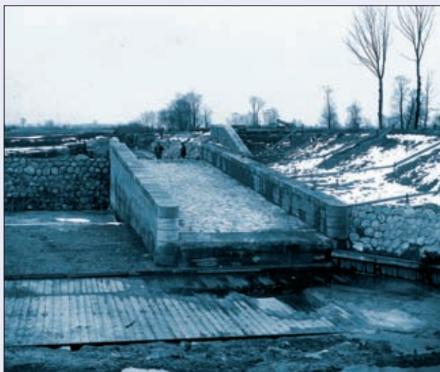
Obr. 79 Konstrukce vorové propusti Malšovického jezu (1926)
