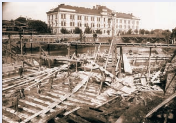
Obr. 66 Bourání roštu pod základy Moravského pevnostního mostu (1910)
