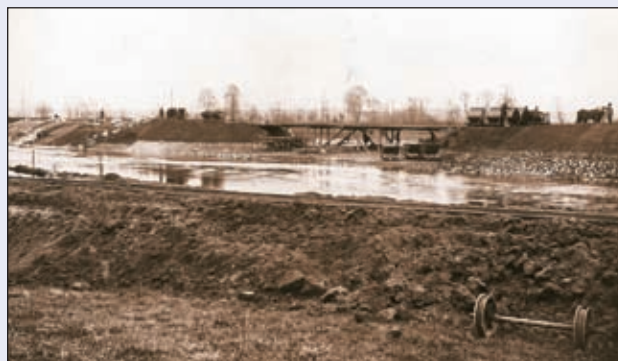
Obr. 67 Práce na úpravě Orlice v prostoru dnešního železného mostu Malšovice-Slezské Předměstí (1914)
