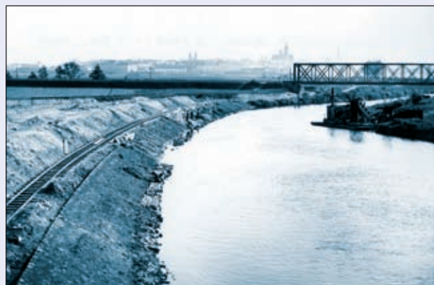
Obr. 51 Upravené labské koryto nad železničním mostem trati Hradec Králové-Letohrad (1910)
