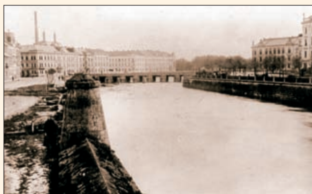
Obr. 32 Pražský pevnostní most na Labi s částí batardeau a panenkou (1907)
