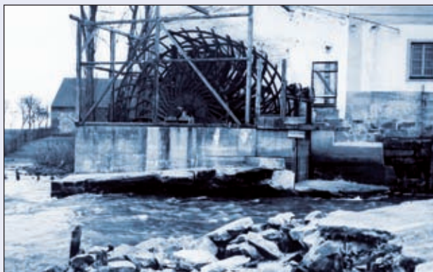
Obr. 23 Zbytky vodního kola mlýna Podhůra (1941)
