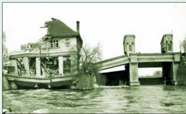
Obr. 61 Jez I a vodní elektrárna po havárii (1932)
