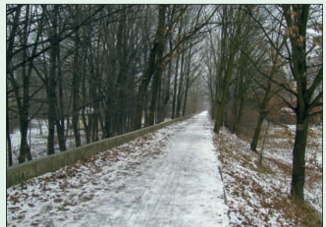
Obr. 95 Rekonstruovaná levobřežní svodná hráz na Orlici
