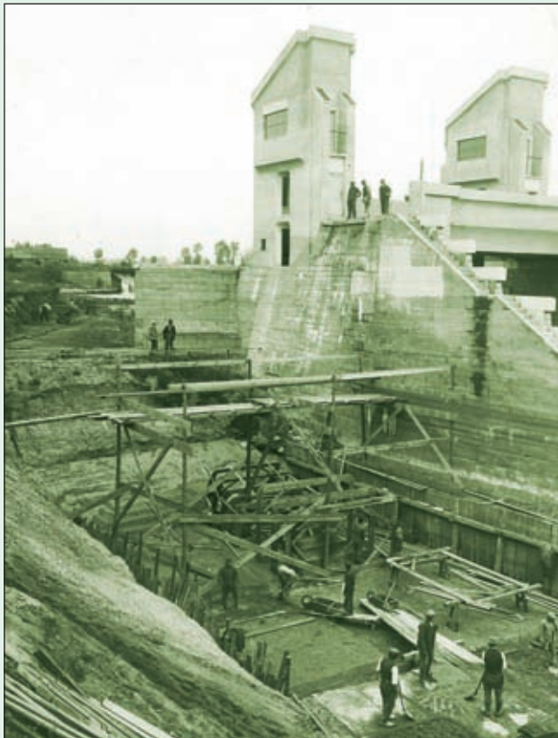
Obr. 39 Pilíře a budky strojoven jezu I. na Labi v Předměřicích nad Labem – architekt P. Janák
