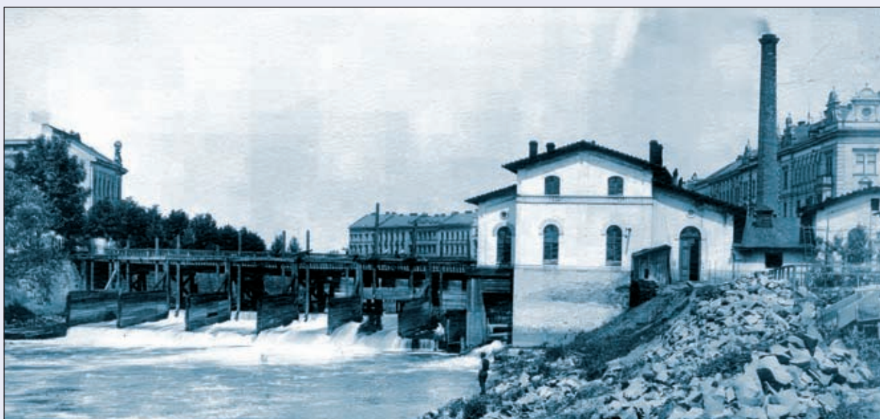
Obr. 16 Pevnostní jez hučák na Labi s budovou městské vodárny (1908)
