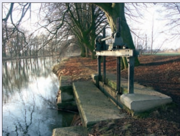
Obr. 19 Náпустný objekt Labského náhonu v Předměřicích n. L.
