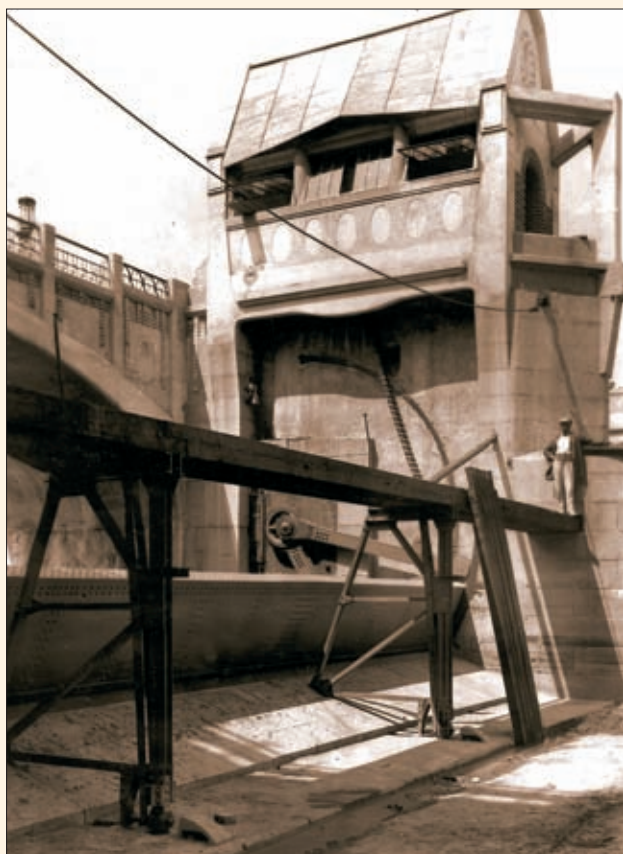
Obr. 54 Detail výzdoby pilíře a strojovny jezu (1912)
