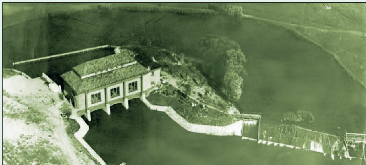
Obr. 76 Letecký pohled na původní jez mlejnek a malšovickou vodní elektrárnu (1921)
