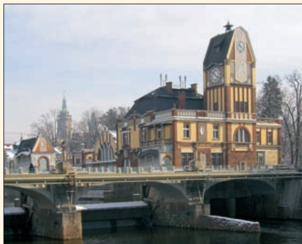
Obr. 55 Celkový pohled na jez Hučák s vodní elektrárnou
