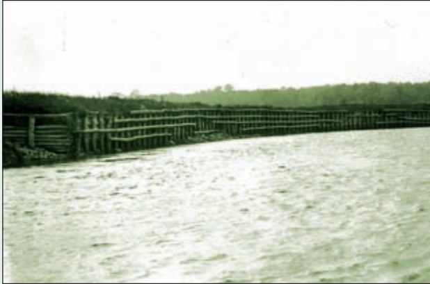
Obr. 11 Zajištění břehu srubovými stěnami (1909)
