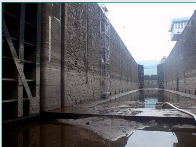
Vyčerpaná malá plavební komora Střekov
