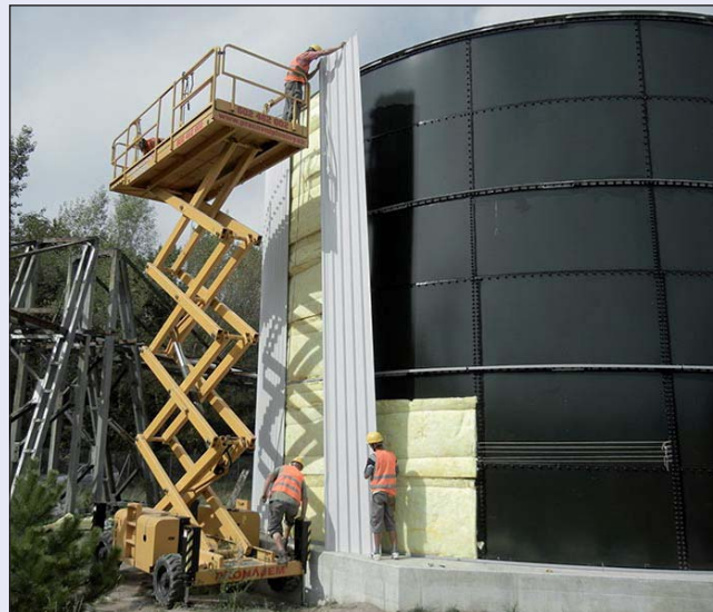
Modernizace BČOV města Pardubice, montáž kalové nádrže
