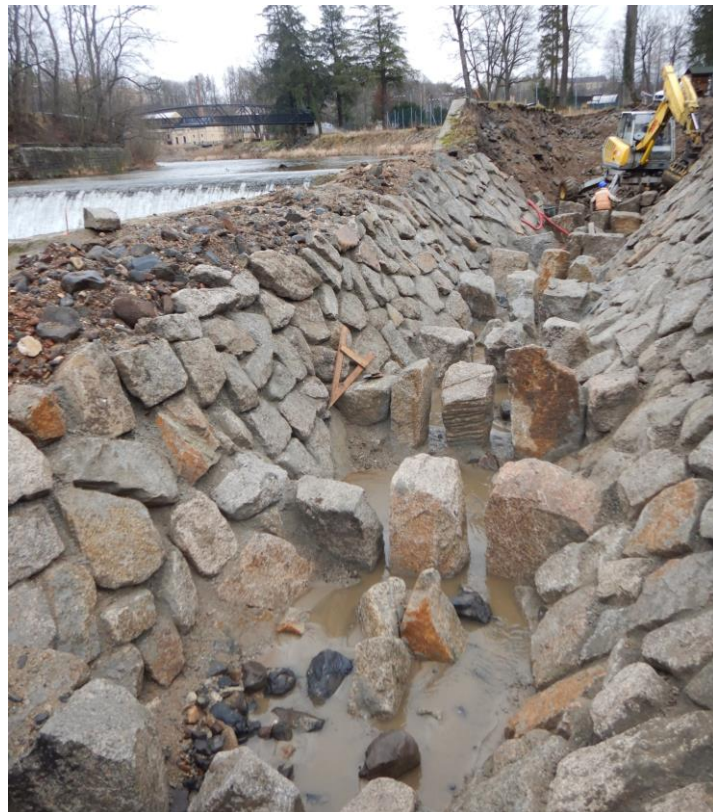
Lichoběžníková část rybího přechodu
