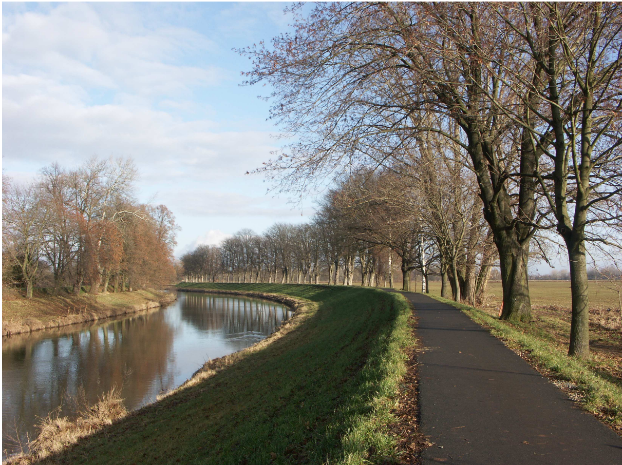
Obr. č. 2 – rekonstruované hráze na Labi (2008)
