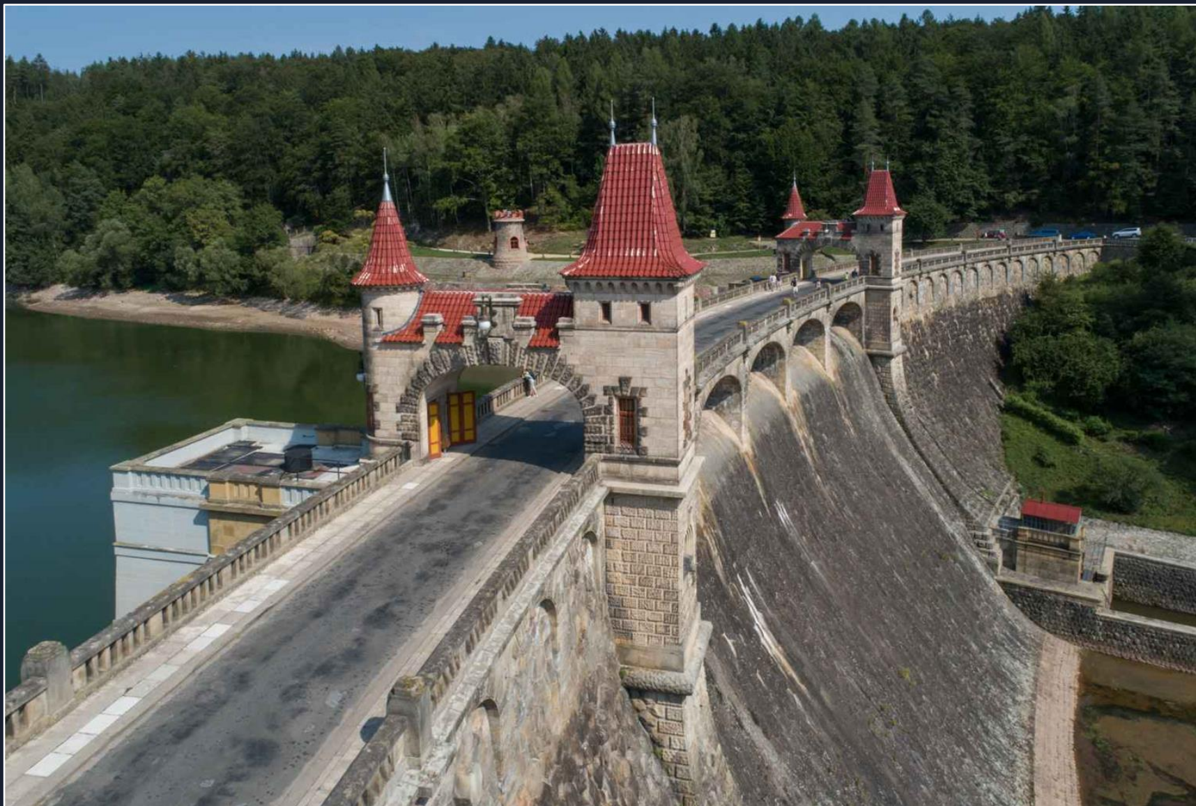
Průjezdové brány a levá šoupátková věž po rekonstrukci
