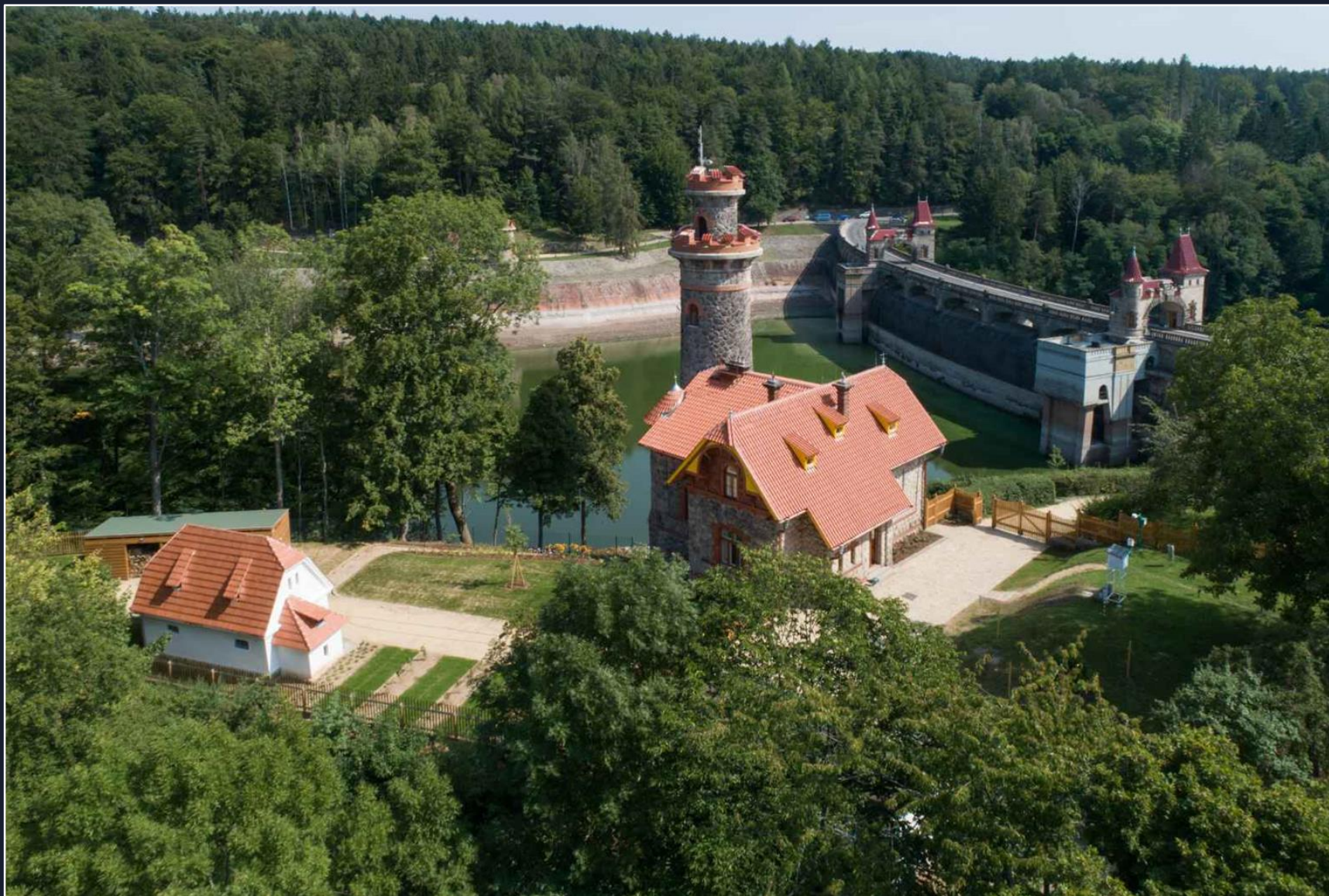
Celkový pohled na areál po rekonstrukci
