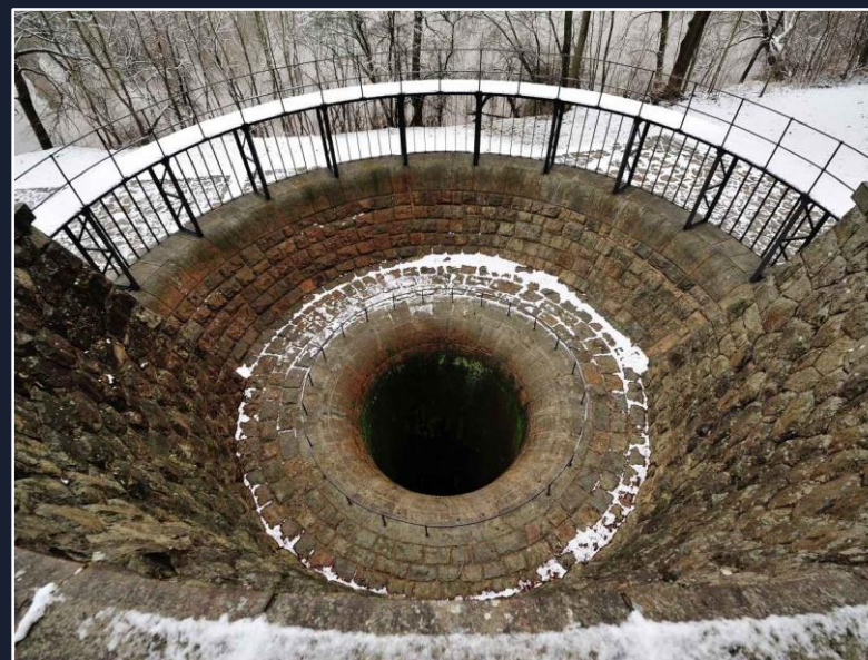
Levý šachtový přeliv
