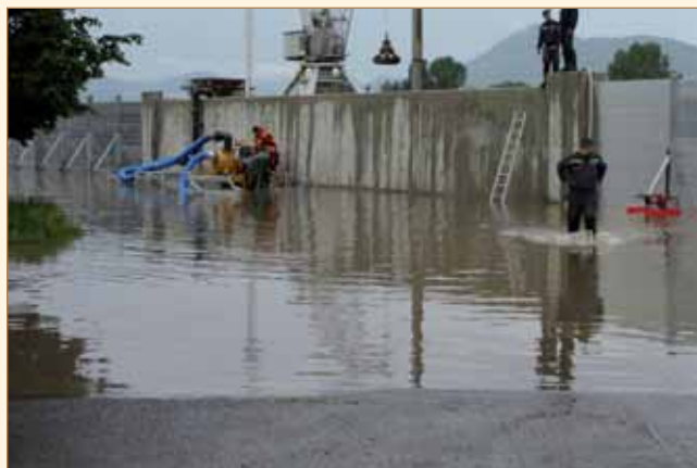
Labe, protipovodňová stěna v Lovosicích
