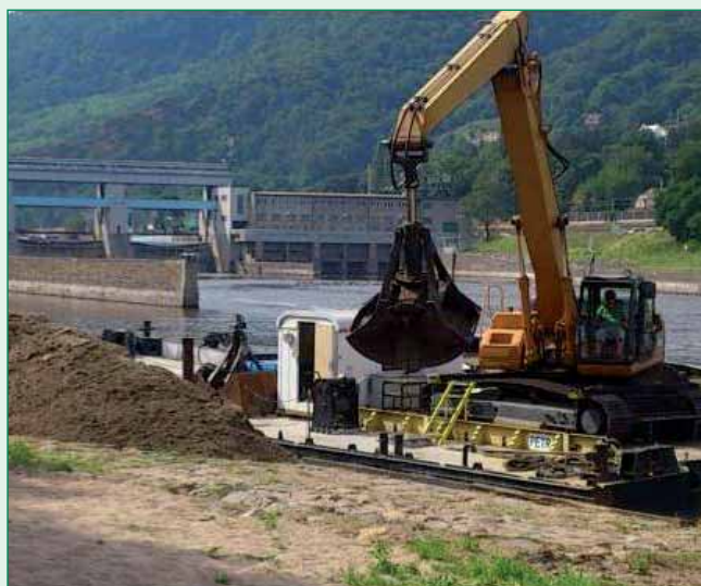
Labe, odstraňování nánosů v dolní rejdě plavebního kanálu Střekov
