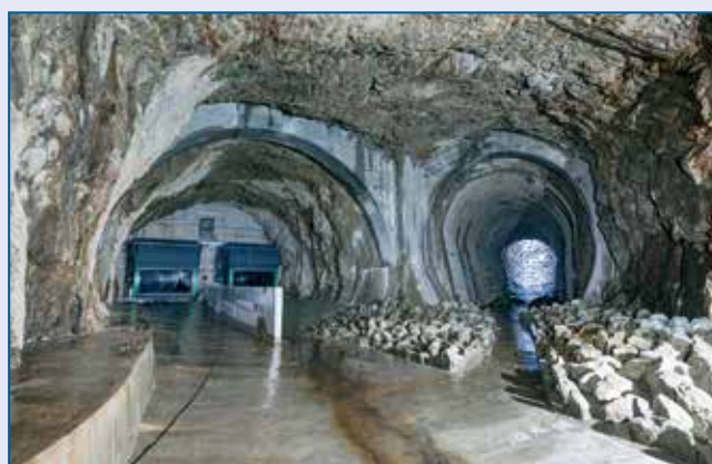
Spodní výpustí na přehradě Labská po rekonstrukci
