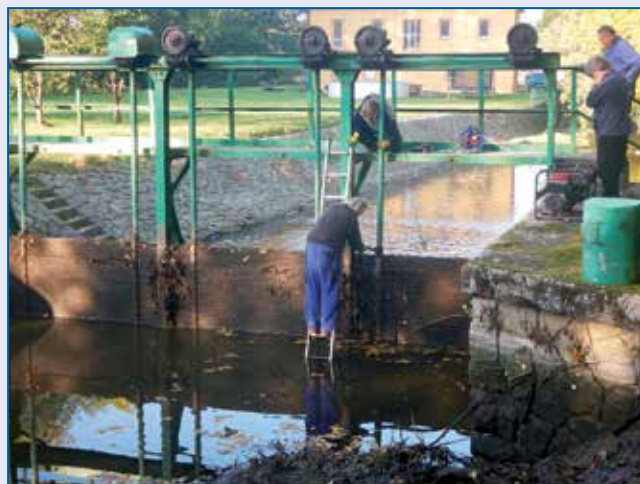
Oprava stavidel na jezu v Blížňovicích
