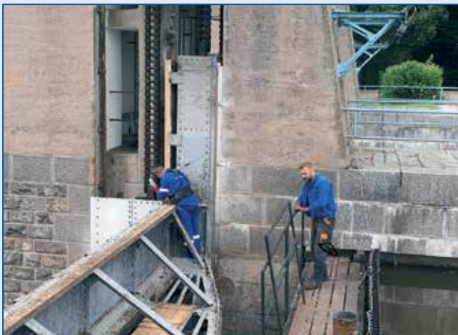
Provozní údržba na jezu ve Smiřicích
