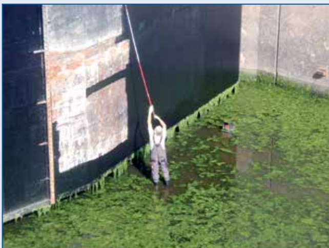
Provádění nátěru vrat plavební komory Lovosice
