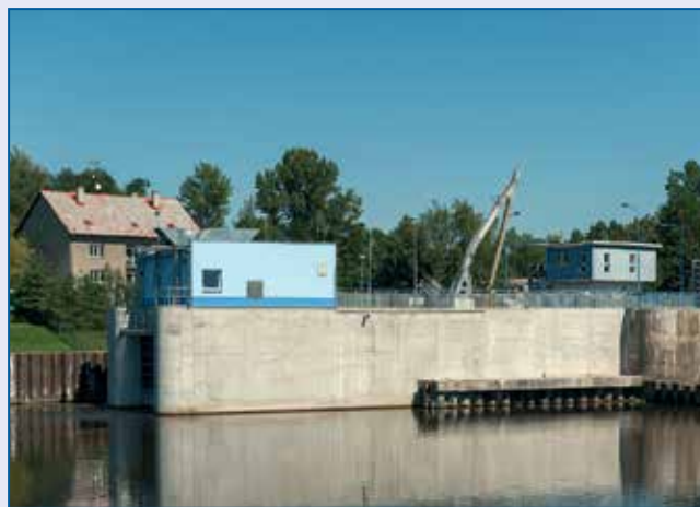
Malá vodní elektrárna Veletov na Labi
