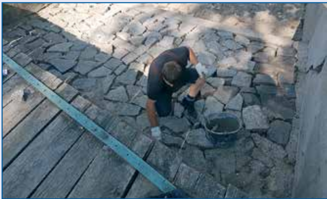
Oprava bezpečnostního přelivu MVN Votřík
