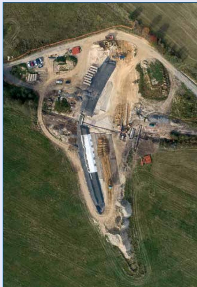
Višňová, Víška, výstavba suché nádrže na Krčelském potoce
