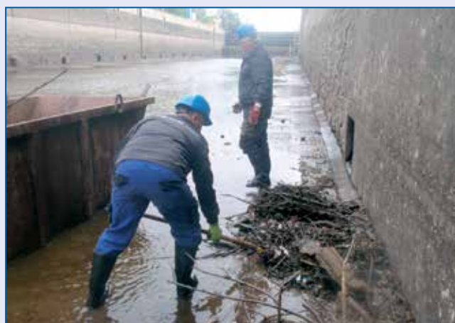
Čištění dna plavební komory Lovosice
