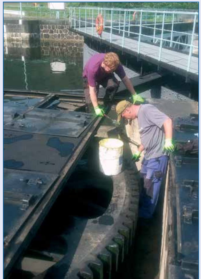
Údržba pohonů velké plavební komory Střekov
