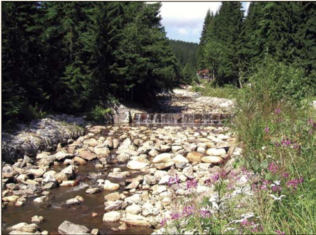
Koryto Úpy v Obřím dole po opravě.
