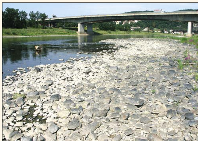
Labe v Děčíně při vodním stavu 146 cm v Ústí nad Labem.
