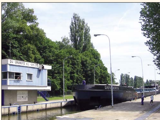
Plavební komora v Brandýse nad Labem.
