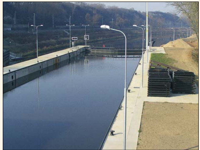
Rekonstruovaná velká plavební komora v Roudnici nad Labem.
