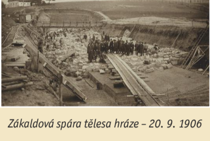
Základová spára tělesa hráze – 20. 9. 1906
