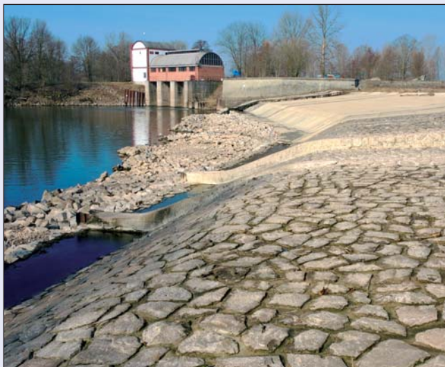
Labe, opravená koruna Opatovického jezu
