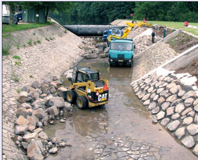
Jizera, oprava obtokového koryta v Dolánkách
