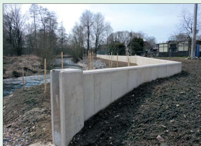
Tichá Orlice, protipovodňová ochrana obce Plchovice
