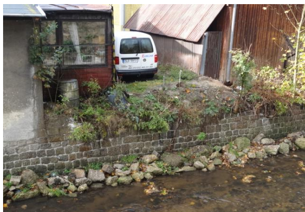
Oprava spárování levobřežní zdi v areálu firmy Nisaform se záhozem u paty zdi
