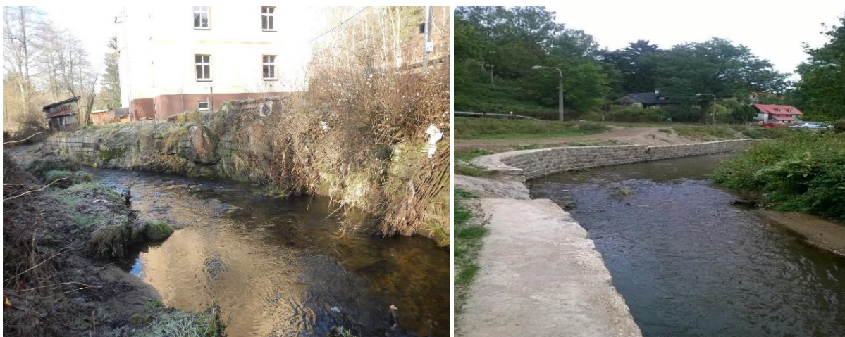
Obnova pravobřežní zdi u řadových garáží nad bytovým domem č. p. 200 v Proseči nad Nisou
