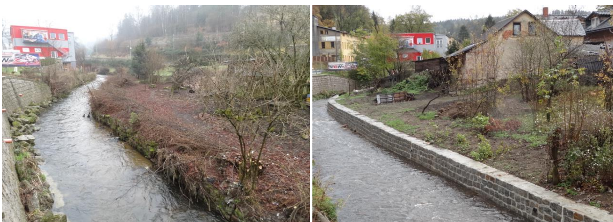
Obnova levobřežní zdi pod prodejnou motocyklů v Proseči nad Nisou
