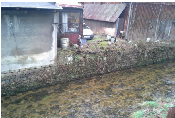
Oprava spárování levobřežní zdi v areálu firmy Nisaform se záhozem u paty zdi
