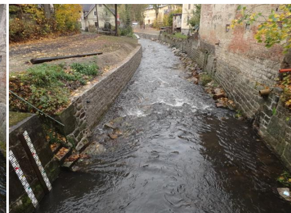
Oprava spárování pravobřežní zdi se záhozem u paty zdi a obnovená levobřežní zeď v úseku pod limnigrafem v Proseči nad Nisou
