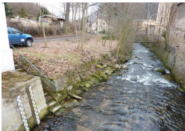
Oprava spárování pravobřežní zdi se záhozem u paty zdi a obnovená levobřežní zeď v úseku pod limnigrafem v Proseči nad Nisou
