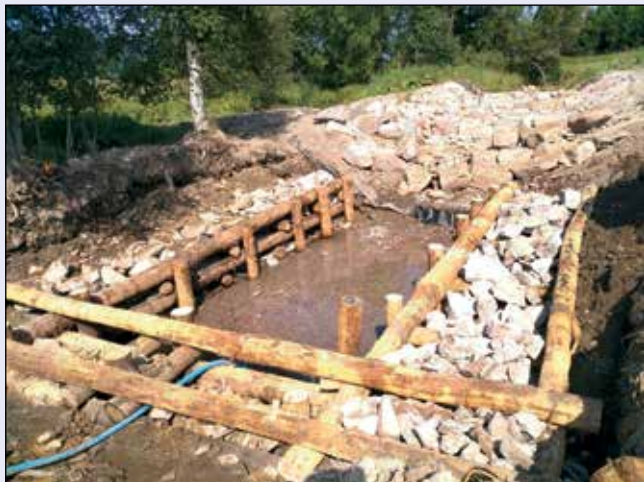
Zařízení pro migrační prostupnost na Divoké Orlici v Orlickém Záhoří – srubová konstrukce vývaru
