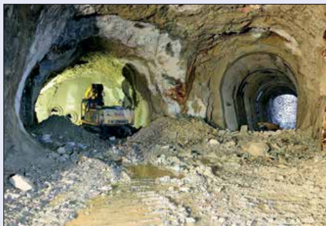
VD Labská, práce v obtokovém tunelu
