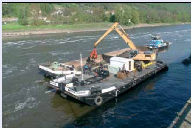
VD Střekov, odstranění nánosů v podjezí
