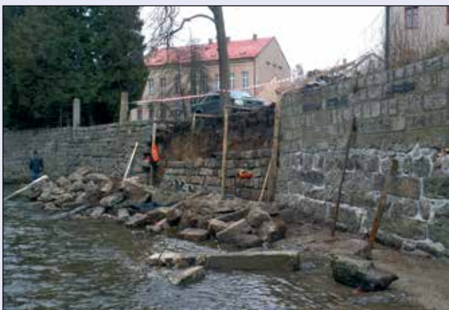
Lužická Nisa, Liberec, oprava koryta
