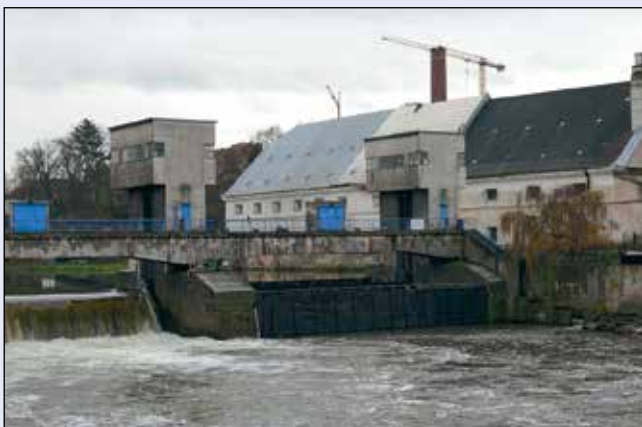
VD Brandýs nad Labem, oprava levého jezového pole
