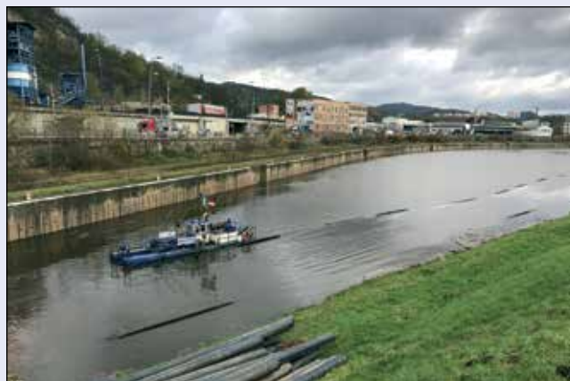
Odstraňování nánosů v Západním přístavu v Ústí nad Labem
