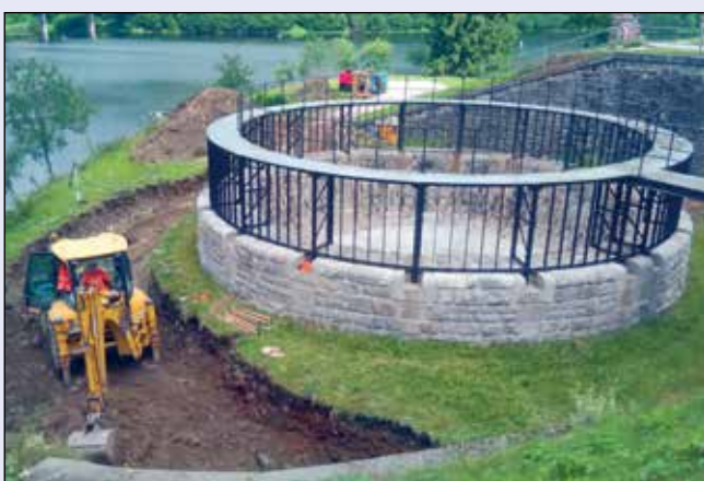
VD Labská, zahájení zemních prací na ochraně šachtového přelivu
