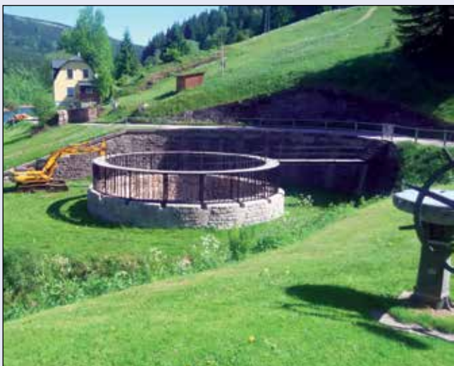
VD Labská, šachtový přeliv před zahájením zemních prací
