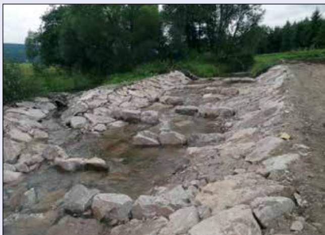
Zařízení pro migrační prostupnost na Divoké Orlici v Orlickém Záhoří – balvanitý skluz
