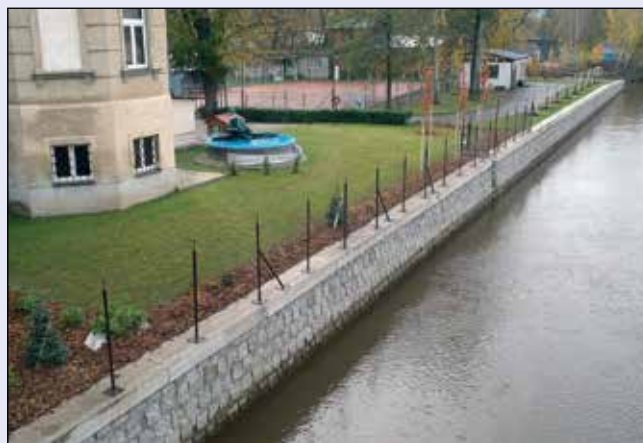
Jizera v Turnově po dokončení rekonstrukce
