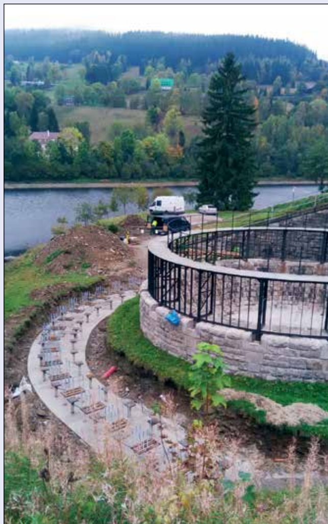
VD Labská, hotová základová konstrukce ochrany šachtového přelivu
