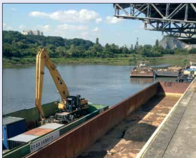
Odstraňování nánosů v Centrálním přístavu v Ústí nad Labem
