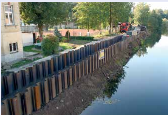
Jizera v Turnově při rekonstrukci
