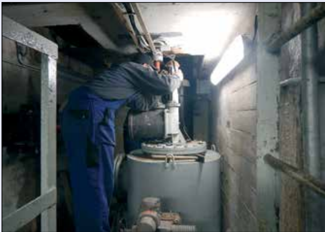
VD Roudnice nad Labem, údržba trojcestného ventilu v hydrostatickém jezu
