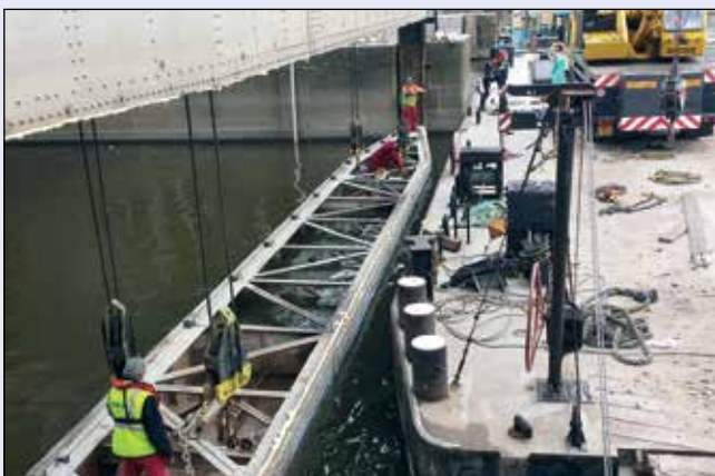
VD Střekov, provizorní hrazení IV. jezového pole
