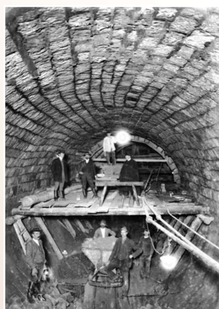
Část souboru unikátních fotografií z výstavby obtokových tunelů, na kterých jsou vidět pomůcky používané na stavbě
