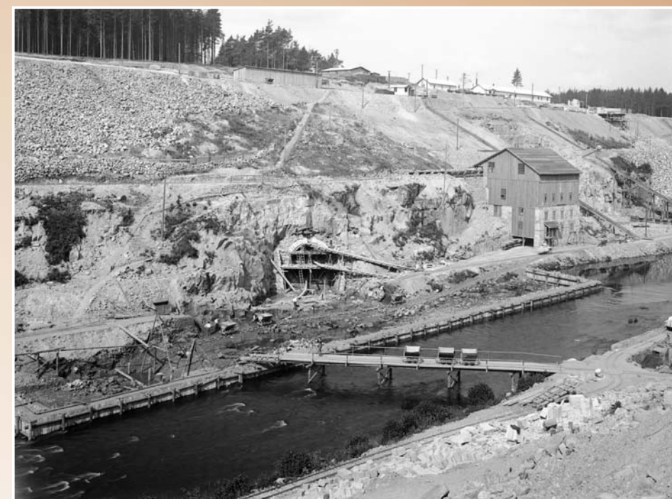
Na fotografii z 30. 6. 1911 je vidět dolní ústí pravého obtokového tunelu, zatím s lešením, a v pozadí lešení v místě pravé šoupátkové šachty, která je součástí domu hrázového.
