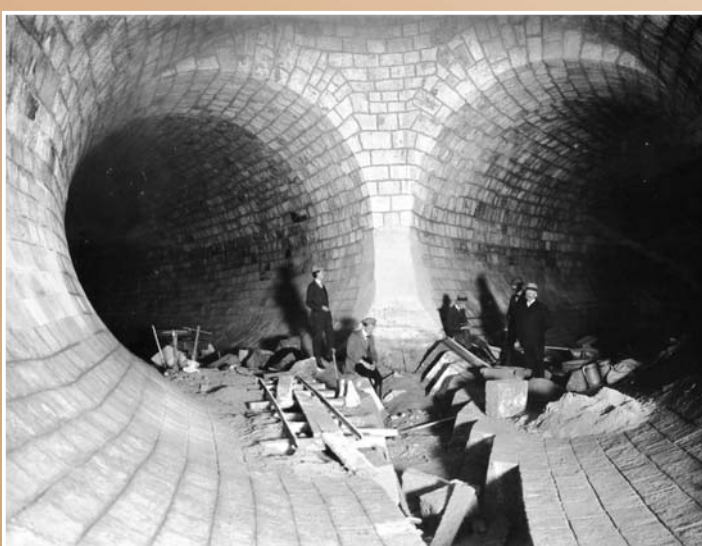
Rozvětvení štol v levém a pravém obtoku na výkresu z projektu a ve skutečnosti. Zatímco pravý obtok je zcela vyzděný, v levém zůstalo skalní dno.
