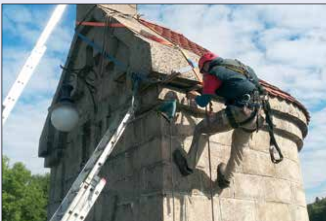
Albrechtický potok, přehrada Mlýnice, oprava spárování manipulačních věží
