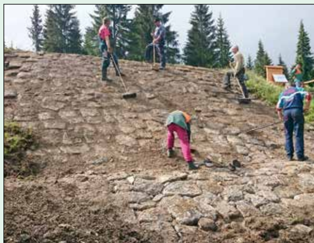
Čištění dlažeb návodního líce zachované části přehrady, 2016
