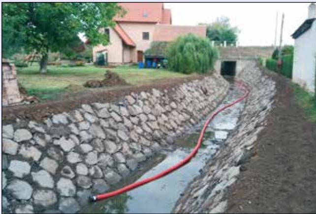
Porák, Čejkovice, rekonstrukce opevnění
