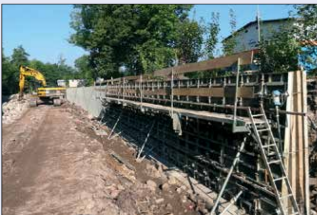
Úpa, Kalná Voda, oprava zdi
