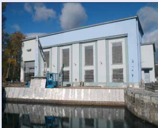
Labe, MVE Lobkovice po celkové rekonstrukci
