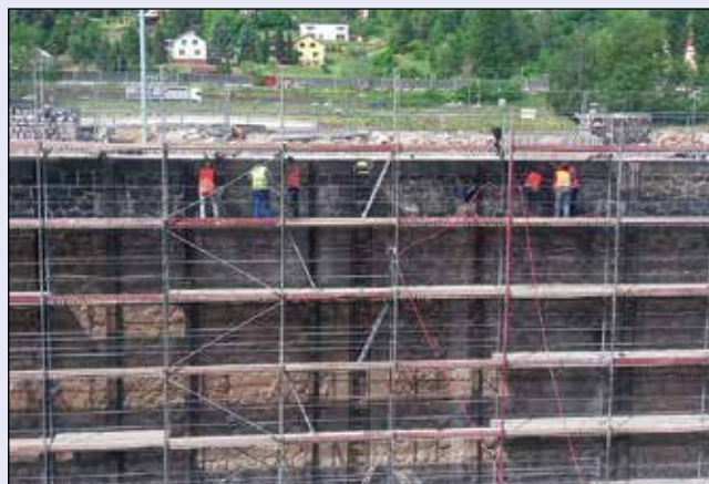
Labe, Střekov, oprava zdi velké plavební komory
