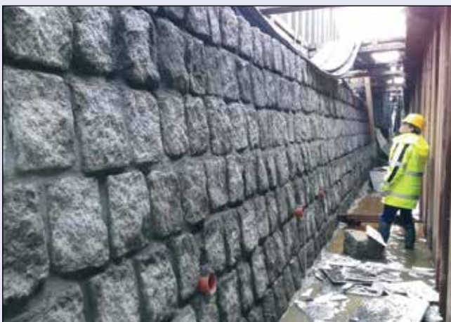
Jizera, Turnov, rekonstrukce břehového opevnění
