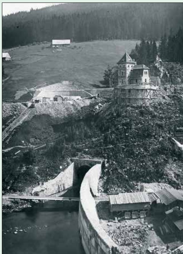
Vtok do obtokového tunelu s předhrázkou, 1913
