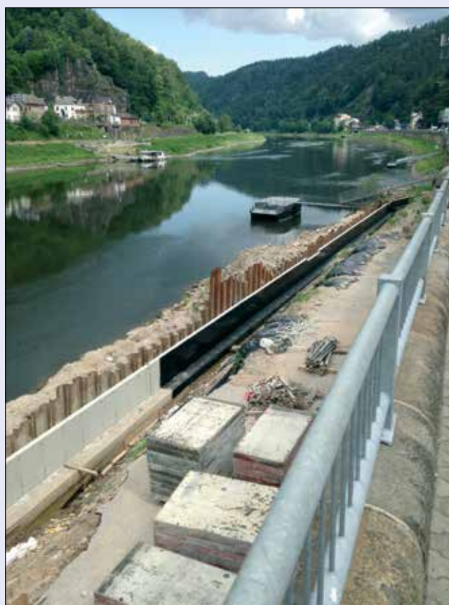
Labe, Hřensko, oprava břehového opevnění
