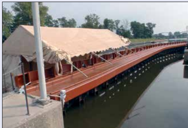
Labe, Lovosice, oprava nátěrů svodidel plavební komory
