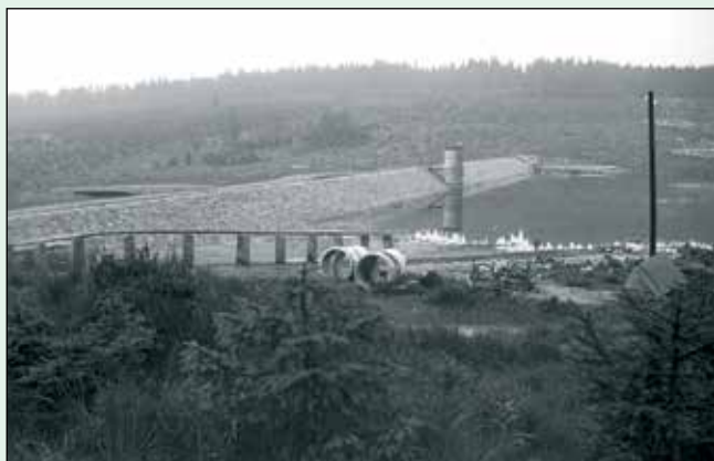
Dokončená přehrada na Bílé Desné, 1915
