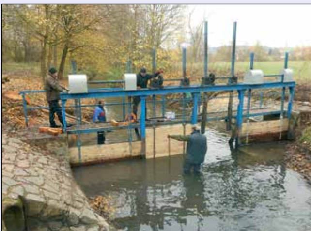
Libuňka, Ktová, oprava stavidel jezu
