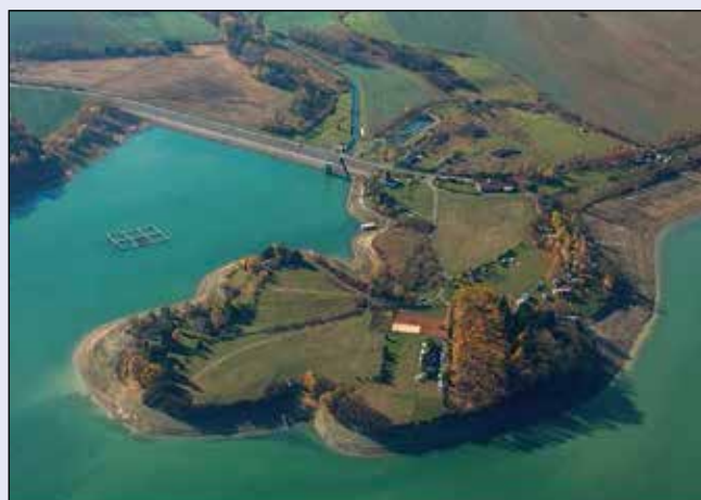
Rozkošský potok, nádrž Rozkoš, 2016
