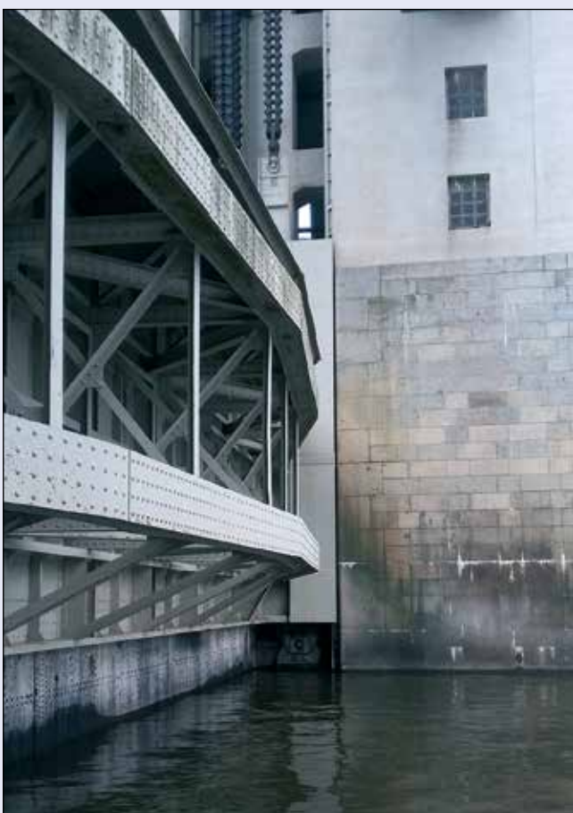
Labe, Střekov, hradící konstrukce po opravě deformace bočních štítů
