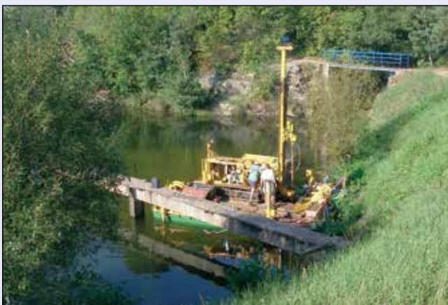
Vrchlice, Velký rybník, obnova spodních výpustí
