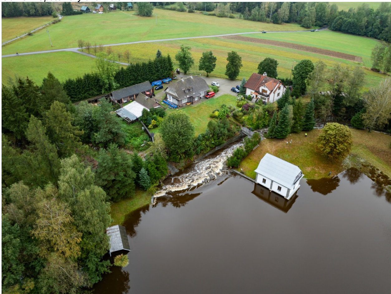
Obr. 4 – VD Hamry 14.9.2024 v podvečer – přepad přes bezpečnostní přeliv
