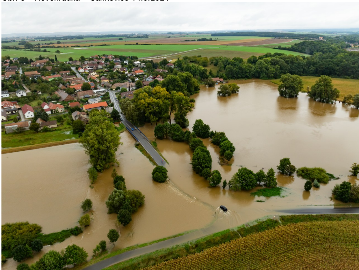
Obr. 6 – Rozlív Novohradky v Úhřetické Lhotě 14.9.2024 po poledni omezen ochrannými hrázemi
