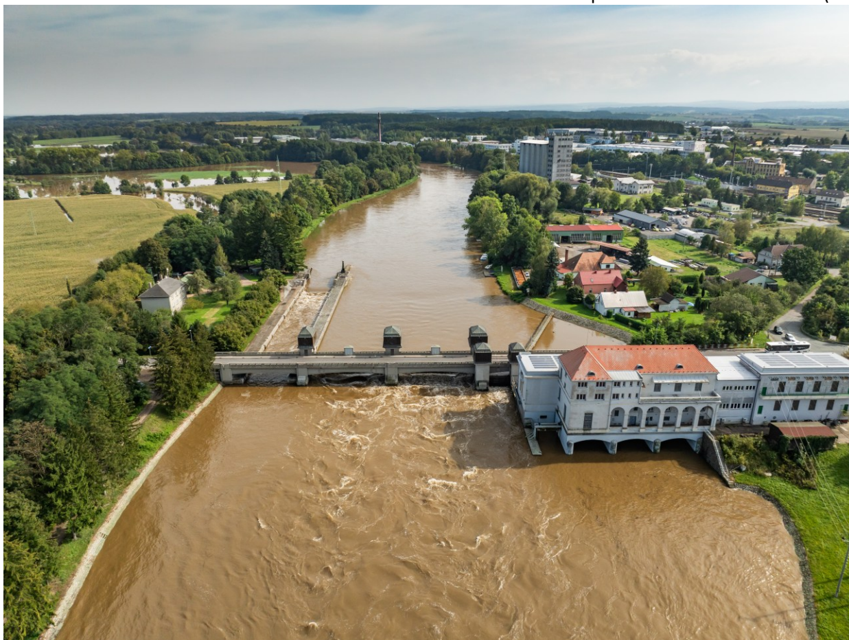
Obr. 7 – VD Přebouč na Labi 16.9.2024 – využití plavební komory k převedení povodňového průtoku
