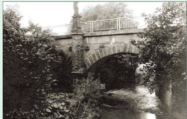
Původní silniční most a úprava
