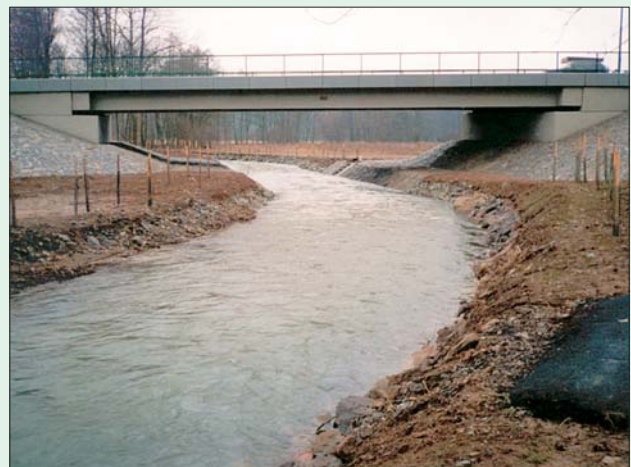
Nový silniční most a úprava
