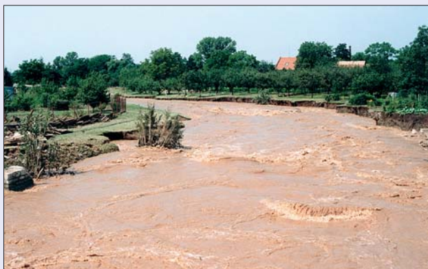
Dědina, koryto pod železničním mostem v Dobrušce v době povodně
