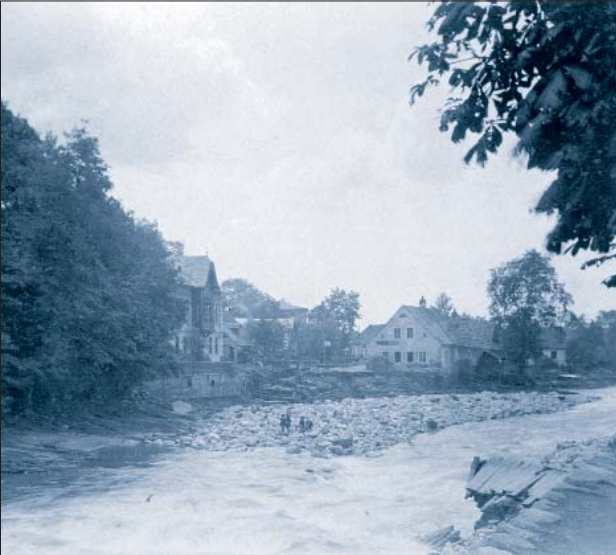
Abb. 34 Flussbett der Elbe in Vrchlabí nach dem Hochwasser, 1897
