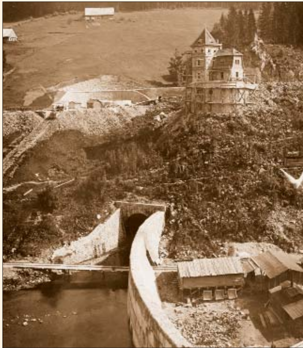
Abb. 46 Schutzanlage am Einlass in den Ablauftunnel, 1913
