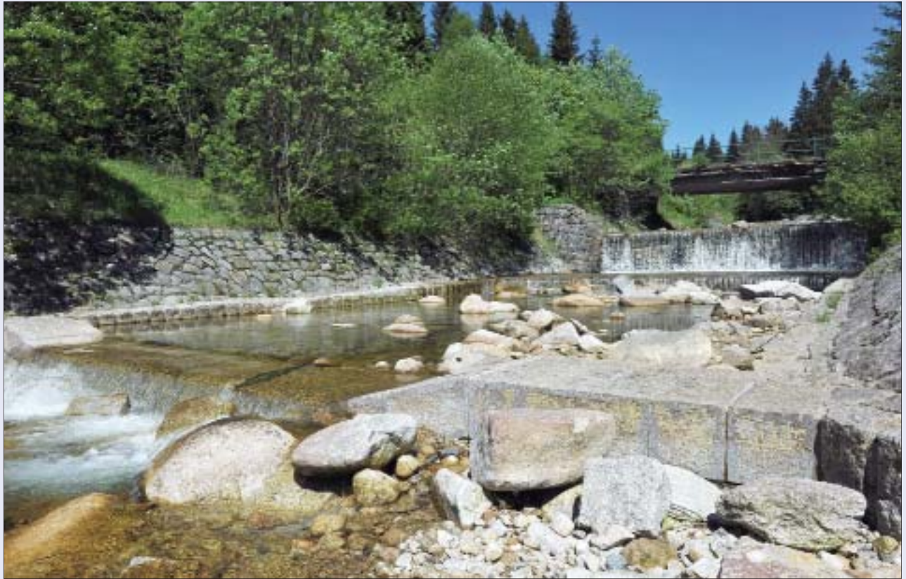
Abb. 61 Verbauungsarbeiten an der Elbe oberhalb des Zusammenflusses mit der Bílé Labe (Weißwasser)
