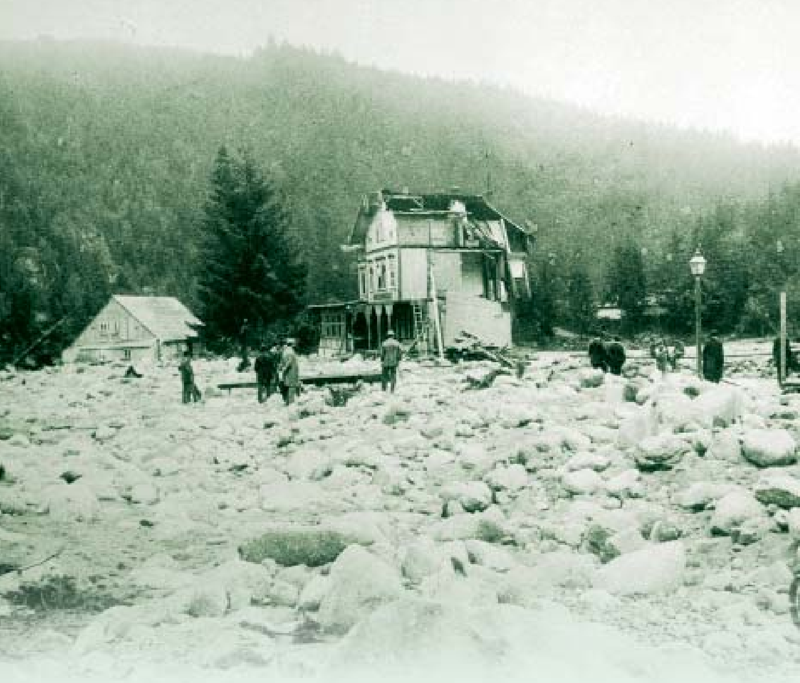
Abb. 21 Vom Hochwasser 1897 zerstörtes Hotel „Deutscher Kaiser“ in Špindlerův Mlýn
