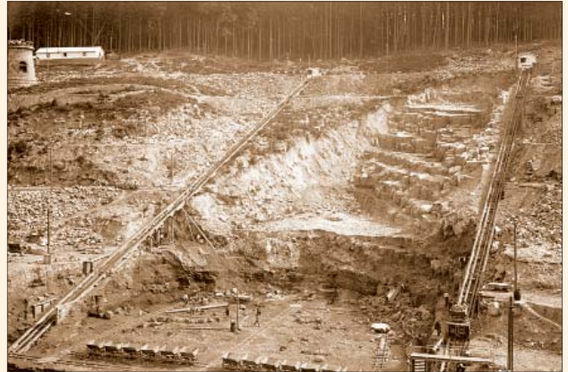
Abb. 55 Linkselsebische Einkerbung zur Einbindung der Staumauer, 1912
