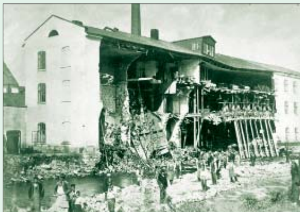
Abb. 22 Eine der zahlreichen vom Hochwasser 1882 zerstörten Webereien in Vrchlabí
