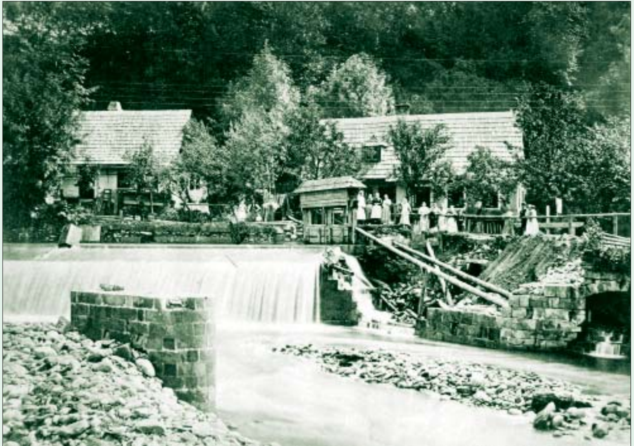
Abb. 25 Zerstörte Brücke beim Wehr Ettlův jez in Vrchlabí, 1882
