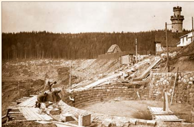
Abb. 56 Abschlussarbeiten am Schachtüberfall auf dem rechten Ufer, 1912
