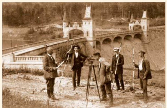
Abb. 59 Schlussvermessungen der Talsperrenanlagen, 1919
