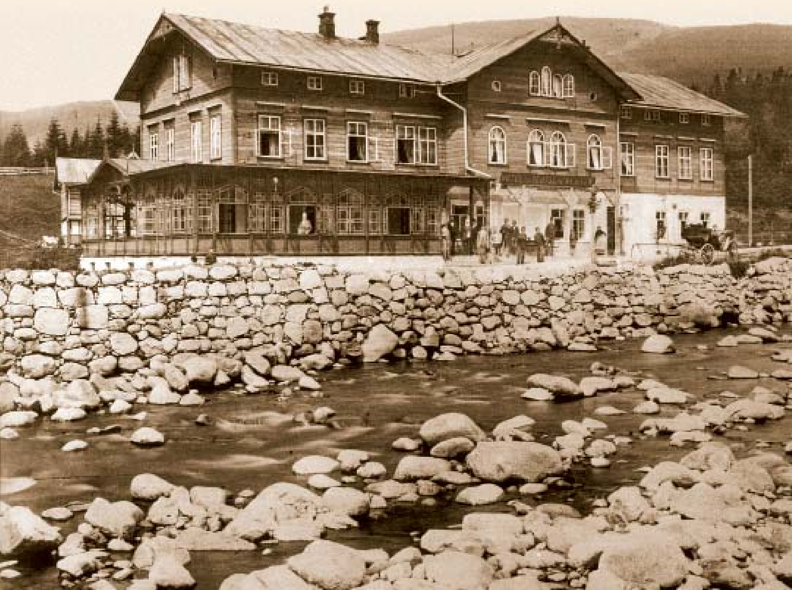
Abb. 32 Uferbefestigung der Elbe vor dem Hotel „Deutscher Kaiser“ in Špindlerův Mlýn, 1896
