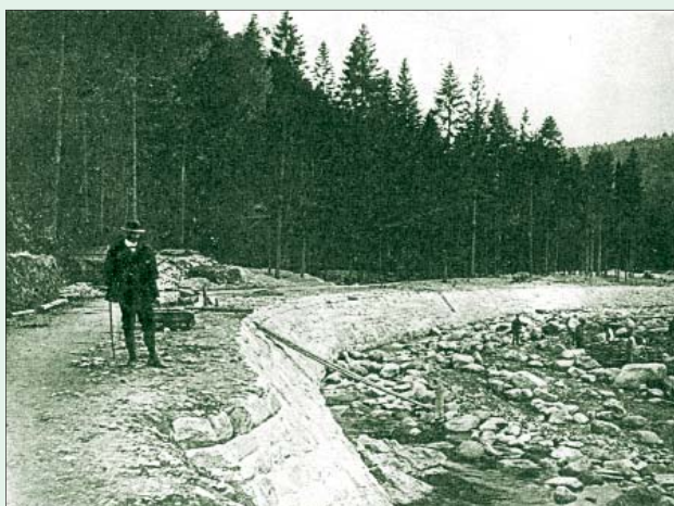
Abb. 38 Ausbau der Elbe unterhalb von Dívčí lávka (Mädelsteg) in Špindlerův Mlýn, 1905
