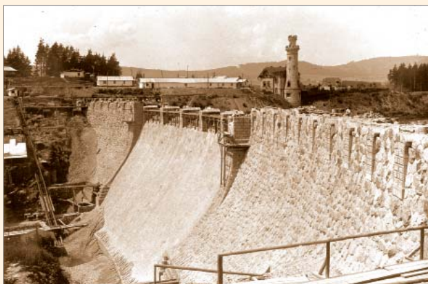
Abb. 58 Ausmauerung der Überlaufanlage in der Dammkrone, 1914
