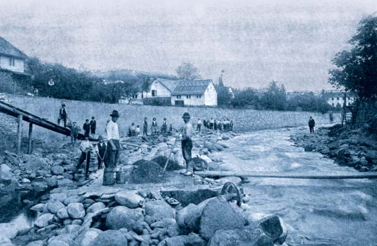
Abb. 33 Ausbaumaßnahmen im Flussbett der Elbe in Vrchlábí, 1908
