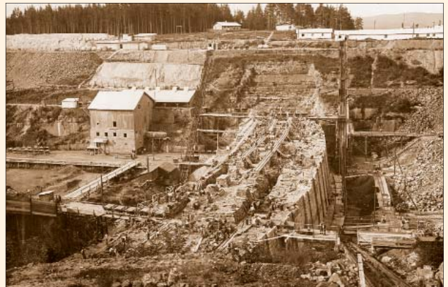
Abb. 57 Stand der Arbeiten im Jahre 1913
