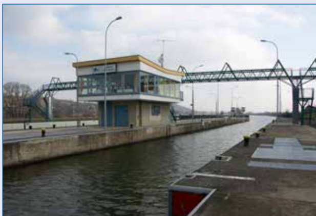
The Elbe at České Kopisty, navigation lock
