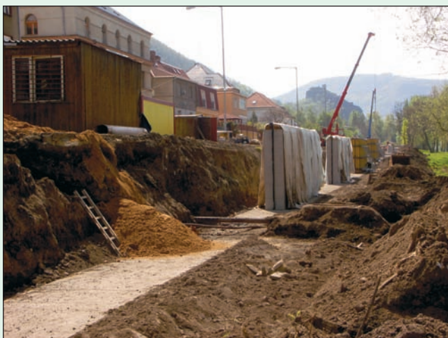
Labe, rozestavěná stavba, Ústí nad Labem - Střekov (2008)
