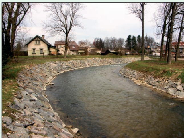
Třebovka, úprava v Dlouhé Třebové
