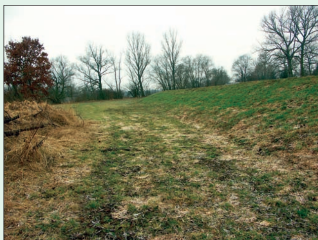
Orlice, protipovodňová hráz v Nepasicích
