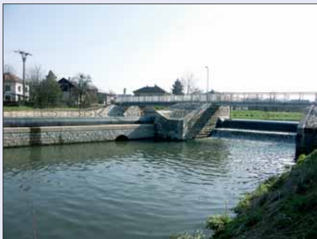
Rekonstruovaný jez na Tiché Orlici v Letohradě
