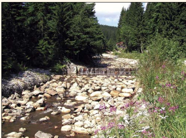
Koryto Úpy v Obřím dole po opravě.
